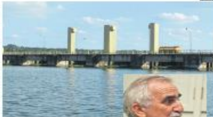
Abitanga tem reservatório, mas a parte inferior do reservatório está com nível baixo
