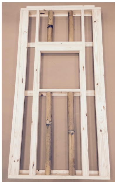
Figura 12. Parede da janela pronta.
