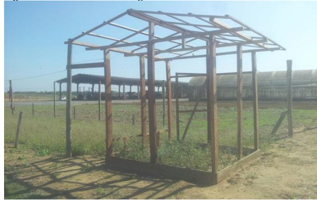
Figura 4. Vista lateral do galinheiro com área para cultivo.
