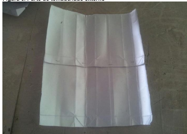
Figura 6. Parte do telhado/lado externo
