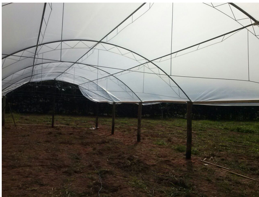
Figura 3. Acabamento da estufa ecológica com plástico
