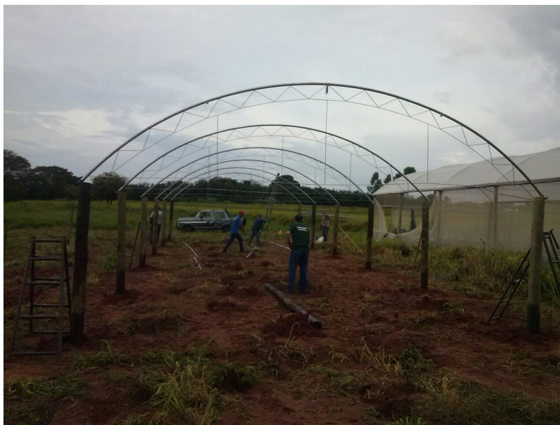
Figura 2. Esqueleto da estufa com eucaliptos tratado
