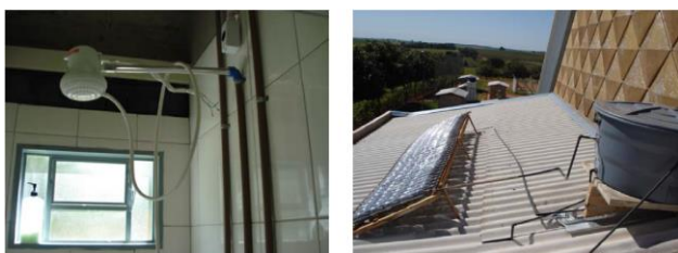
Figura 2. Aquecedor solar instalado no Laboratório de Conforto Ambiental da UNESP –Tupã.
