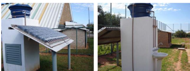
Figura 3. Aquecedor solar instalado no chão, na área experimental do Laboratório de Conforto Ambiental da UNESP – Tupã.
