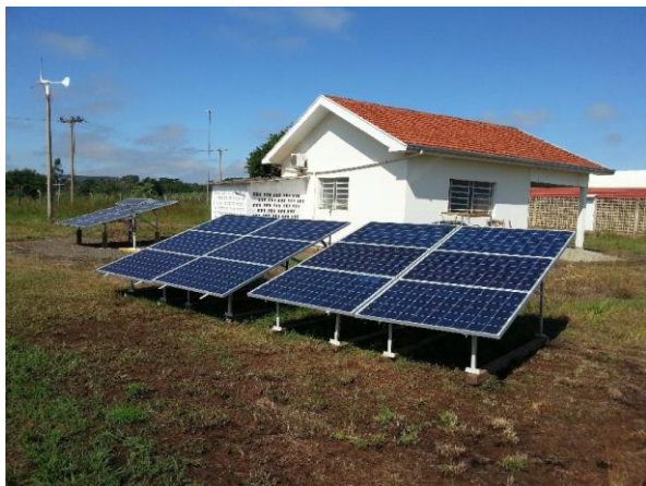
Figura 3 – Arranjo fotovoltaico montado: quatro conjuntos de 750Wp cada
