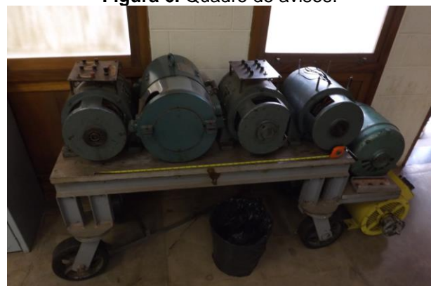
Figura 7. Motores elétricos de grande porte.
