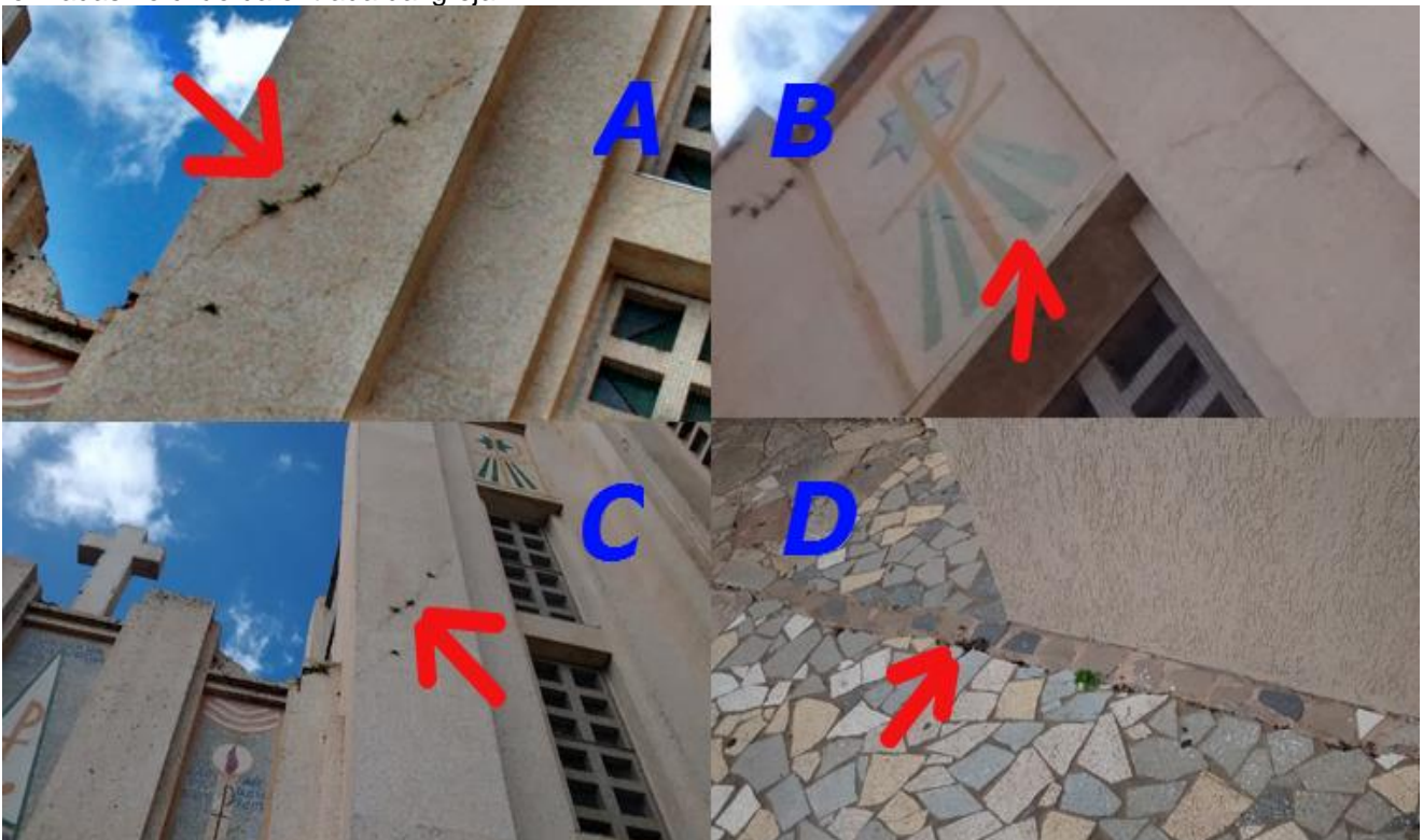
Figura 2 – Visualização de trincas causadas pelo deslocamento. A – Fissura ampliada presente em C; B – Fissura presente na frente da torre; C – Vista geral da lateral da torre, inclusive da fissura; D – Fissuras formadas no chão da entrada da igreja.
