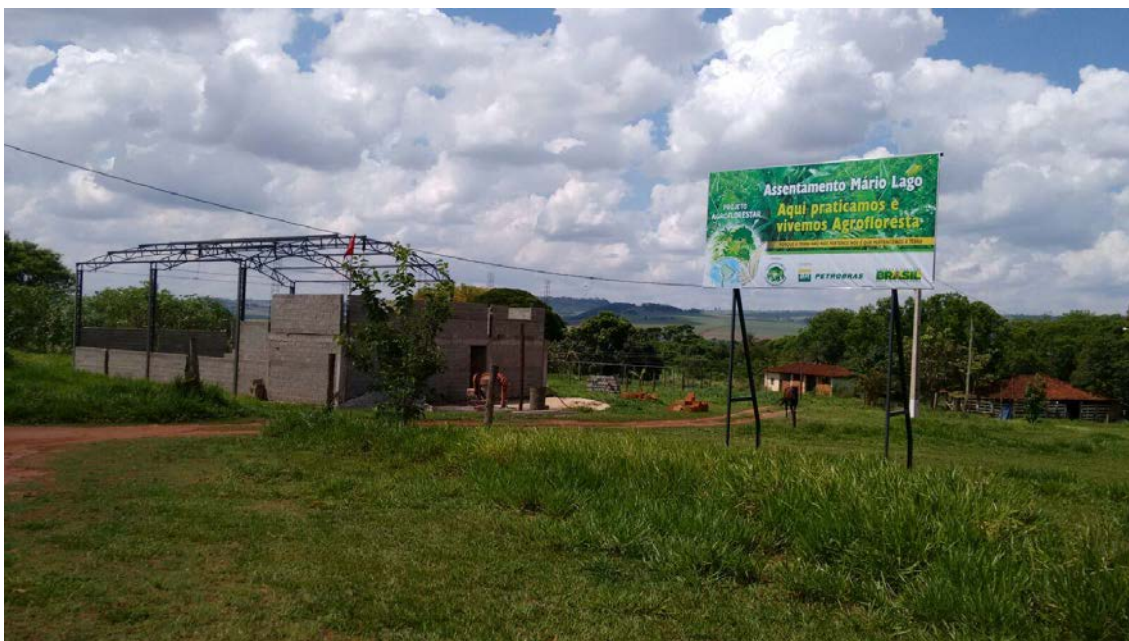
Foto 4 – Construção do Barracão e do viveiro. Fonte: Namastê Messerschmidt. 09/12/2015.
