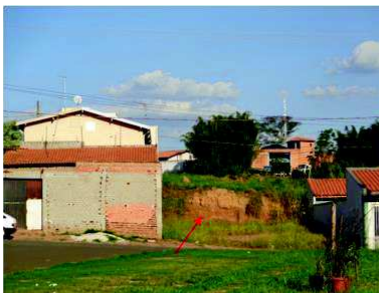
Figura 42: Corte no lote no Jardim Dalla Costa
