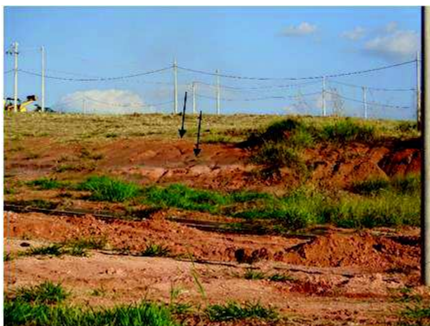
Figura 23: Sulcos erosivos em área de construção
