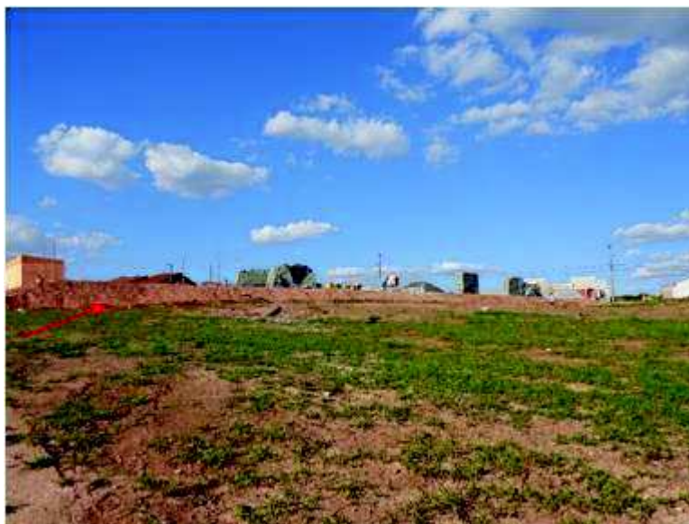
Figura 43: Aterro na construção da creche – Jardim Dalla Costa
