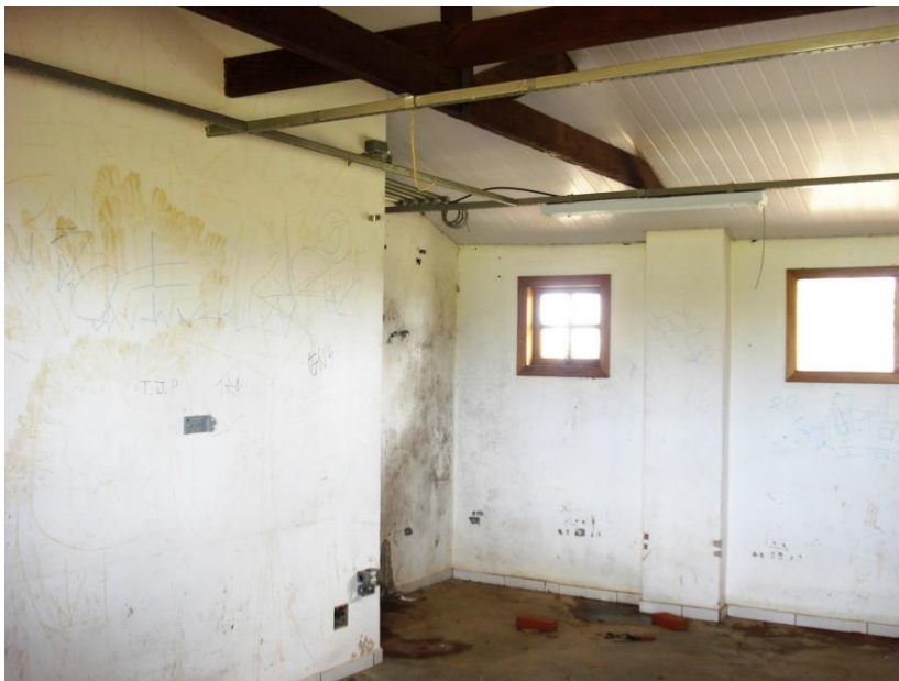
Figura 13: Prédio de controle elétrico do Parque, em visível estado de degradação.
