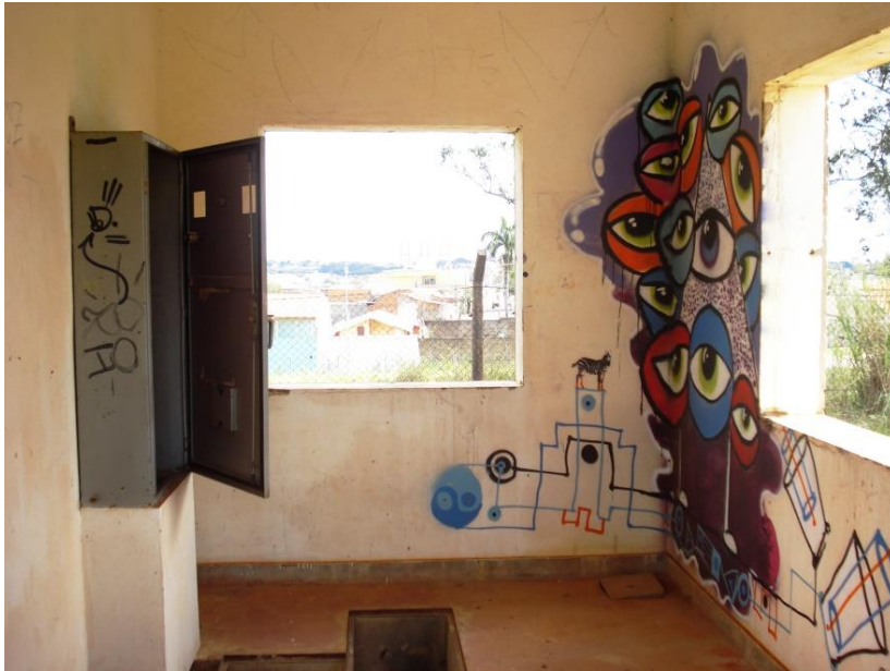
Figura 12: Prédio em desuso e com pichações.
