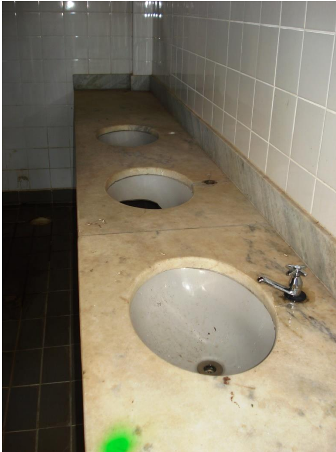
Figura 14: Banheiro do interior do Parque, depredado e sem manutenção.
