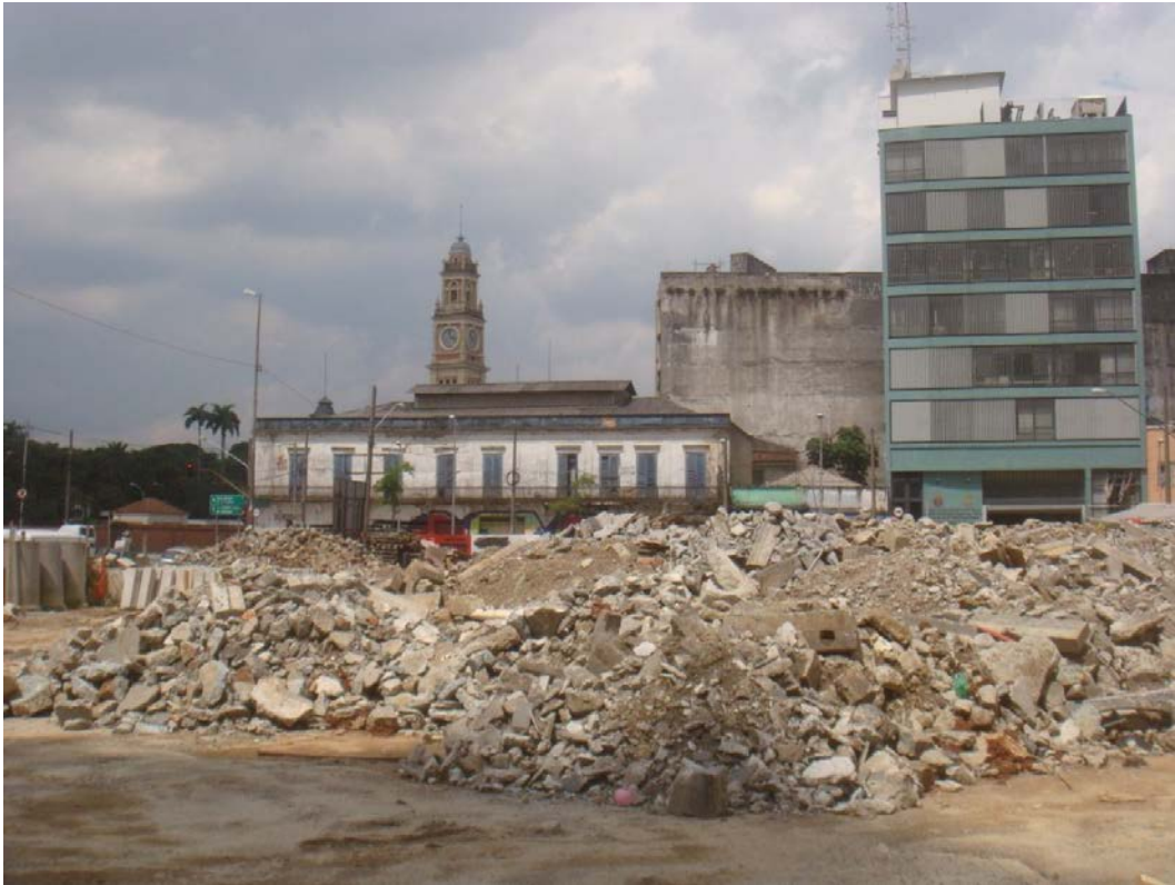
Figura 24 - Quarteirão que foi demolido na Rua Mauá. Ao fundo, no prédio de 6 andares funciona a sede da Guarda Civil Metropolitana. (SOMBINI, 2013, P.124)
