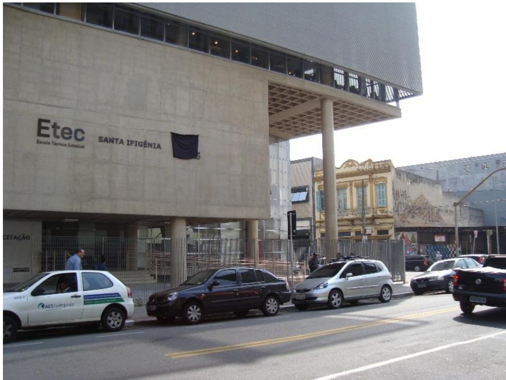
Figura 25 - ETEC Santa Ifigênia, de arquitetura "pós-moderna". Repara-se a grade em todo o perímetro do prédio, e a diferença substancial, "engolindo todo o resto", em relação a arquitetura do entorno. Foto do autor. Data: 18/09/11
