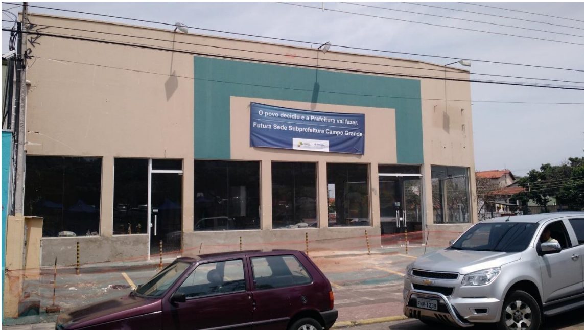
Figura 1: Futura sede da nova Subprefeitura do Campo Grande localizada atrás da Feira. (SILVA, S.A. 2015)
