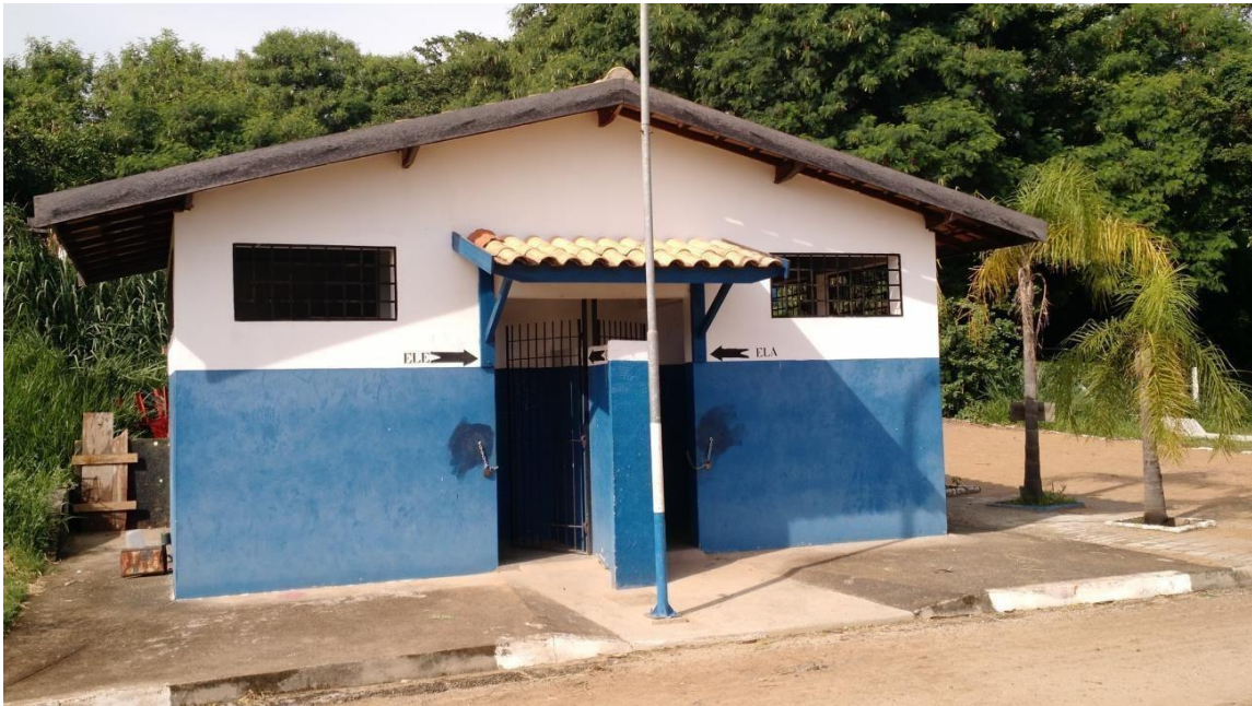
Figura 13: Banheiro do Parque Linear. (SILVA, S.A. 2015)
