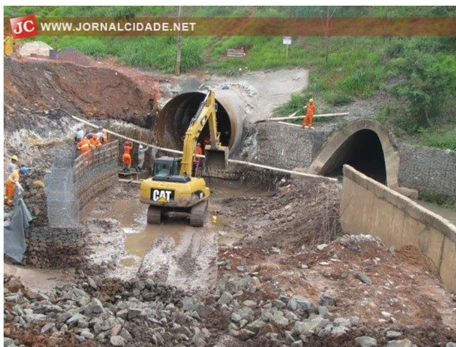
Figura 9 – Obra contra inundação no bairro Jardim Inocoop.
