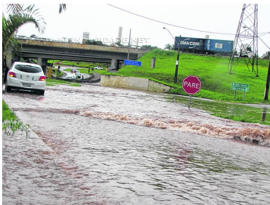
Figura 8 - Avenida Presidente Tancredo Neves fica tomada pela água a cada novo temporal
