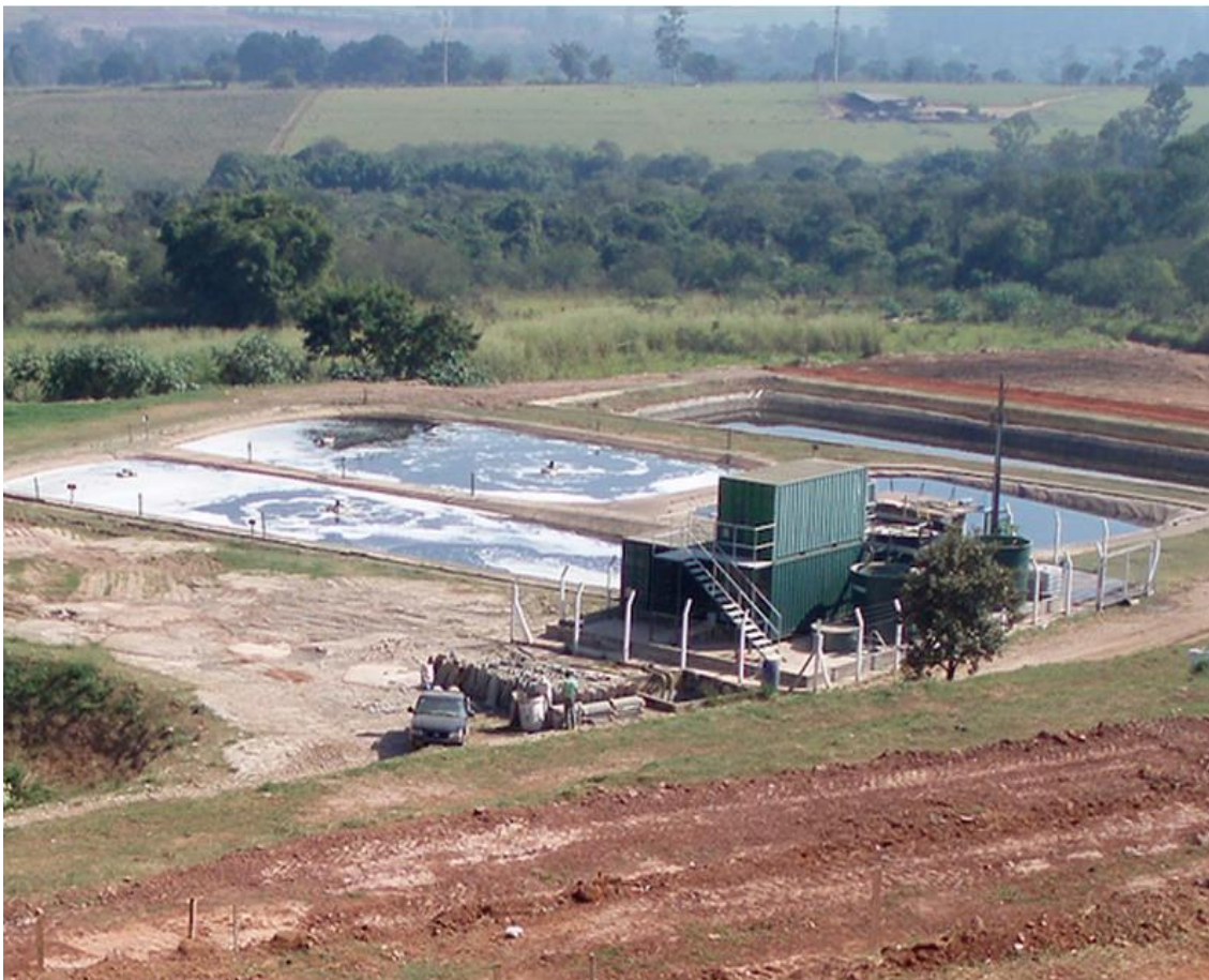
Figura 7: Estação de Tratamento de Chorume de Rio Claro – SP, fonte: SUSTENTARE, 2015.
