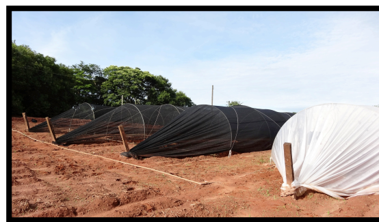
Implantação das estruturas
