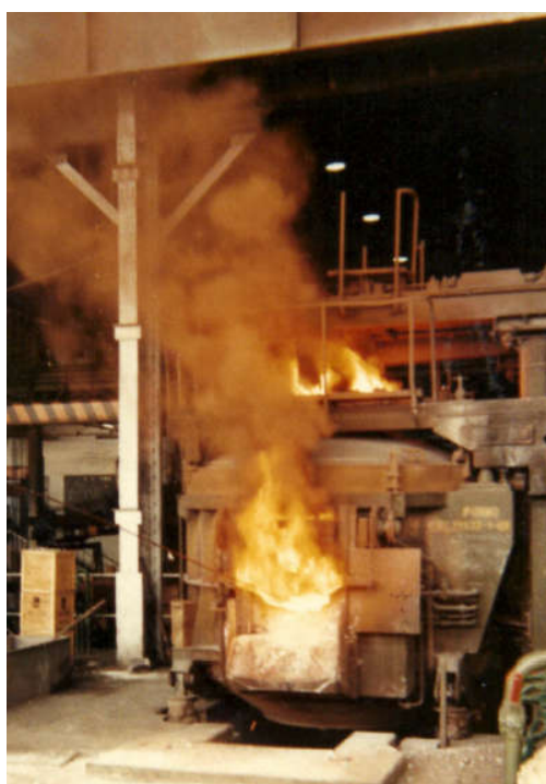
Figura 07: Forno trifásico de eletrodos
