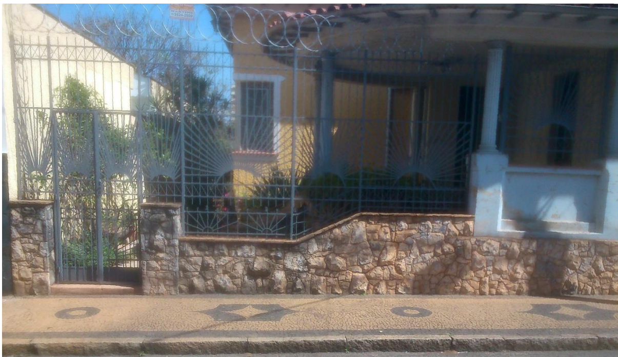
Figura 34 - Residência do município de Rio Claro, mostrando fachada revestida por marmorina
