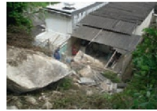
Queda de blocos rochosos em Santos-SP, 2009. Fonte: Tominaga (2009)
