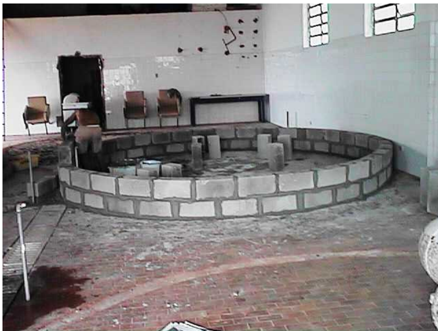
FOTO A – Início da montagem do Laboratório de Recirculação de água do mar.
