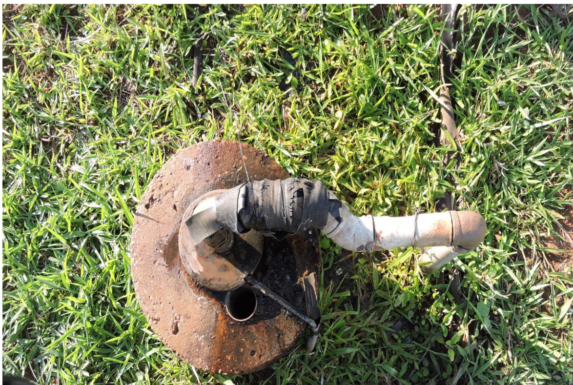
Figura 12 – Sistema de captação de água do poço 1 do Assentamento Timboré
