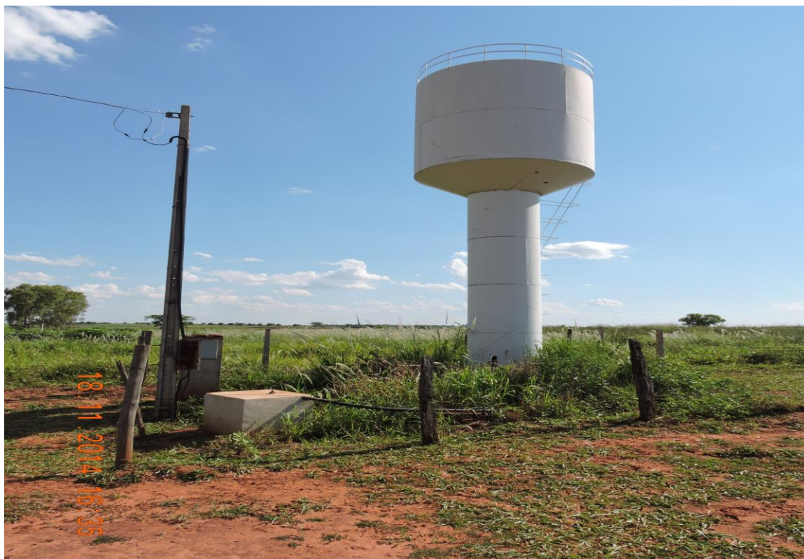
Figura 11 – Sistema de armazenamento de água do poço 5 do Assentamento Timboré
