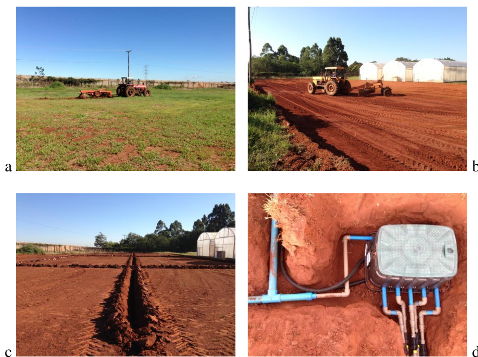
Figura 1. Operações realizadas para construção da área experimental: grade intermediária (a), nivelamento do terreno (b), abertura dos sulcos (c) e instalação do sistema de irrigação (d).
