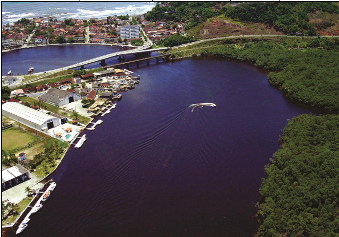
Figura 4: Na figura se vê a Ponte a Sertório Domiciano da Silva mais ao fundo e, em perspectiva mais próxima, avista-se a ponte da linha férrea (ponte do trem).
