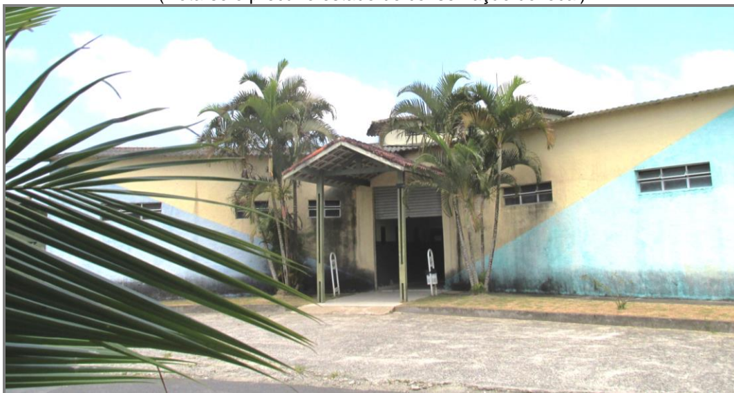
Figura 1: Entrada principal do Centro de Pesquisas do Estuário do Rio Itanhaém. (Nota-se o precário estado de conservação do local)
