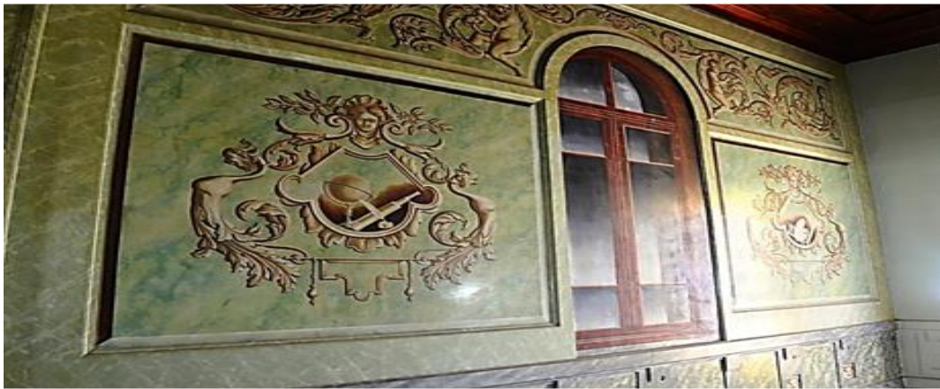
Foto 20: Pintura mural da parede lateral da escada
