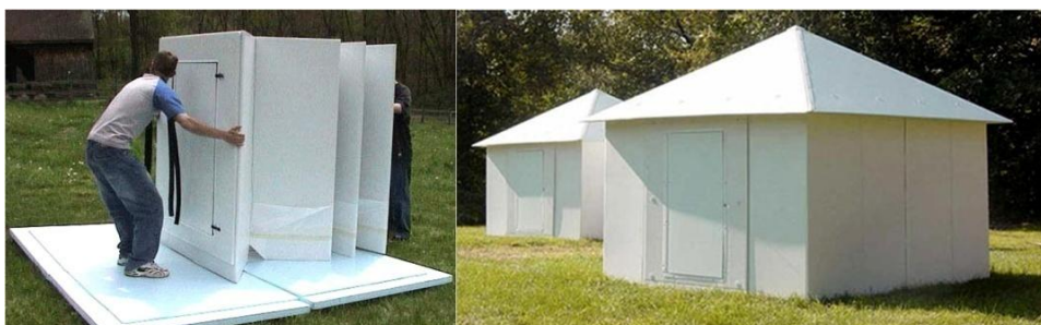
Figura 90 - Montagem da casa de 6 m 2 da Global Village Shelters
