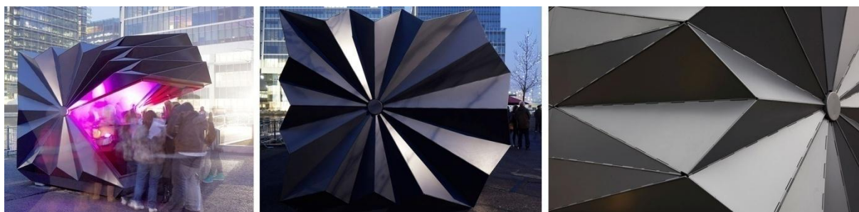
Figura 91 - Canary Wharf Kiosk : aberto, fechado e detalhe das dobradiças metálicas
