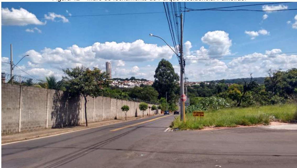
Figura 42 – Muro de fechamento do Parque Residencial Paineiras.
