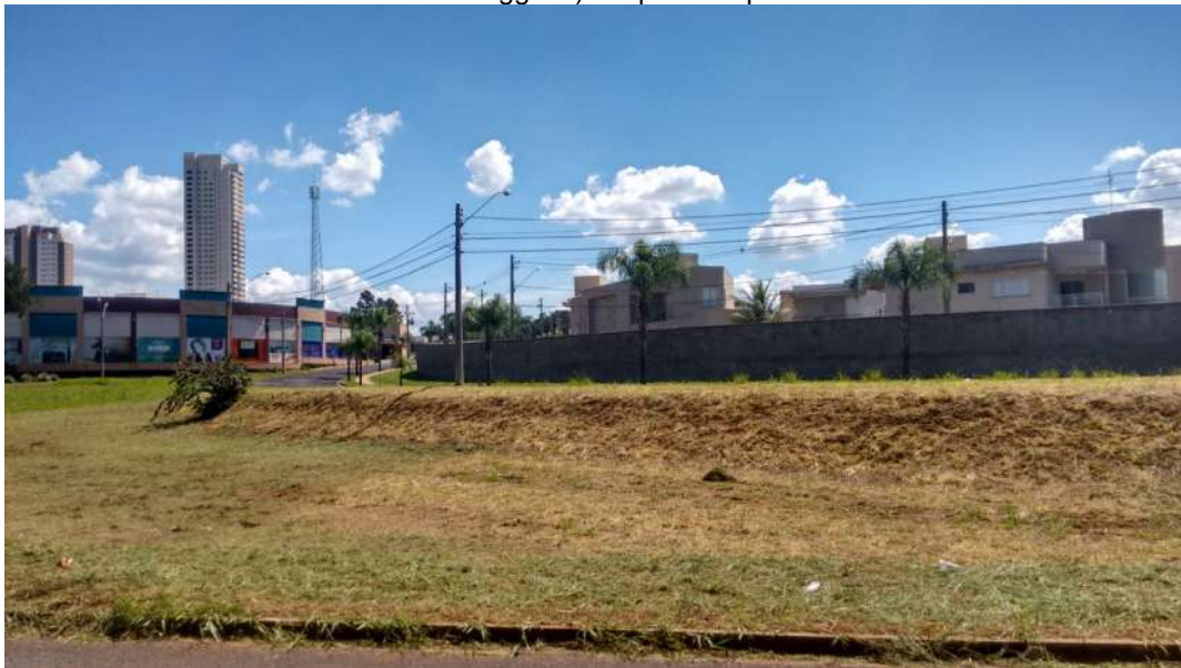
Figura 25 – Vista das torres residenciais em construção, com empreendimentos horizontais (Villaggio Mall e Villaggio II) em primeiro plano.
