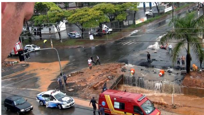
Figura 9: Acidente fatal após as obras de recanalização do Córrego Parque, Americana (SP), 2011. Fonte: EPTV Campinas, 2011.
