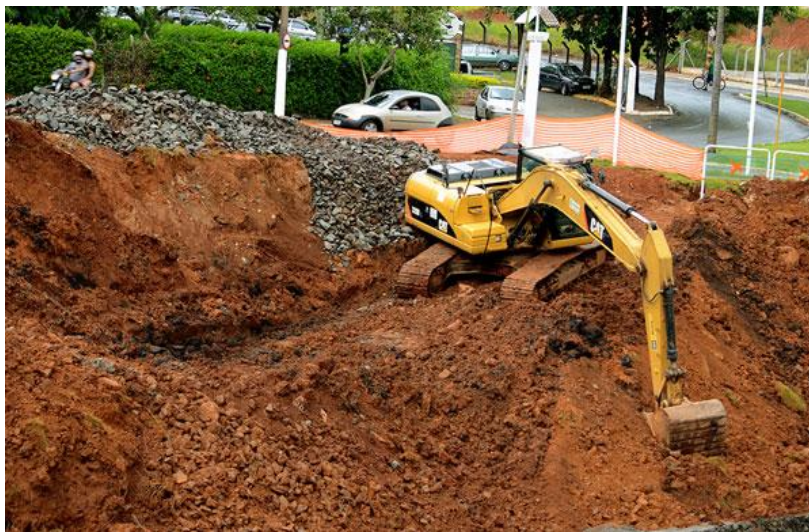
Figura 8: Obras de recanalização do Córrego Parque, Americana (SP), 2011. Fonte: Jornal O Liberal, 2011.
