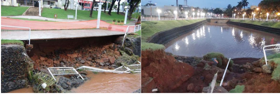
Figura 10: Resultado das chuvas de 25 de março de 2013 nas obras de recanalização do Córrego Parque, Americana (SP), 2011. Fonte: Jornal O Liberal, 2011.
