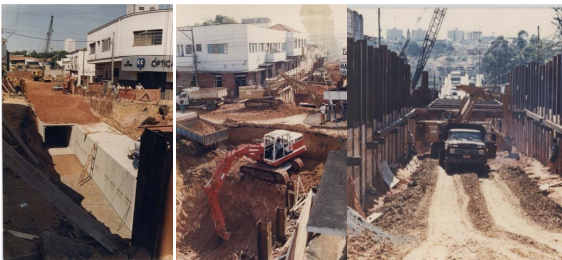
Figura 7: Obras de canalização do Córrego Parque, Americana (SP).
