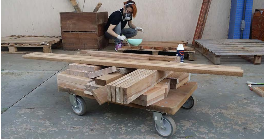
Fig.98: Peças reunidas para aplicação do cupinicida (Fonte: das Autoras)
