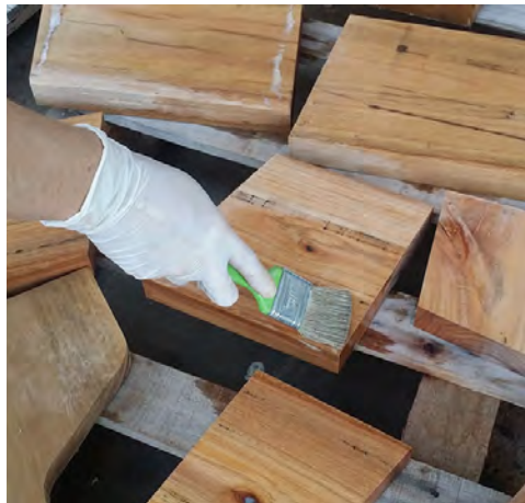
Fig.97: Aplicação do cupinicida (Fonte: das Autoras)
