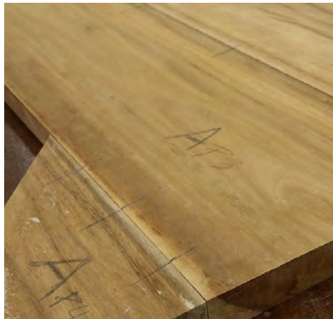
Fig.99: Marcação para guiar a furação (Fonte: das Autoras)
