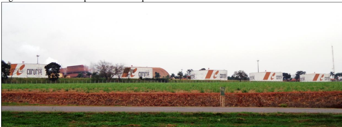
Figura 6: Usina Coruripe/Iturama: tanques de armazenamento de etanol.
