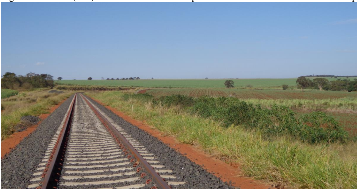
Figura 8: Iturama (MG) - Obra da FNS situada aproximadamente a 2 km da Usina Coruripe
