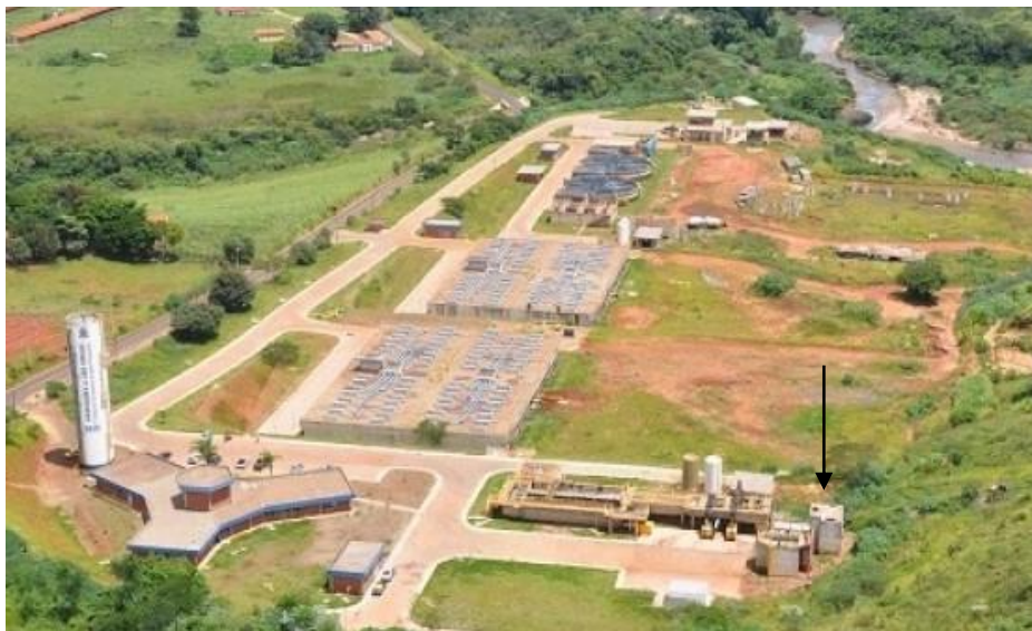
Figura 5: Estação de Tratamento de Esgoto de São Carlos – ETE Monjolinho
