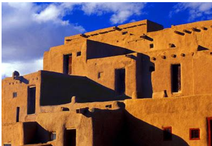
Figura 2.02 – Grande construção em adobe, situada no Novo México, de acordo com Picorelli (2011)
