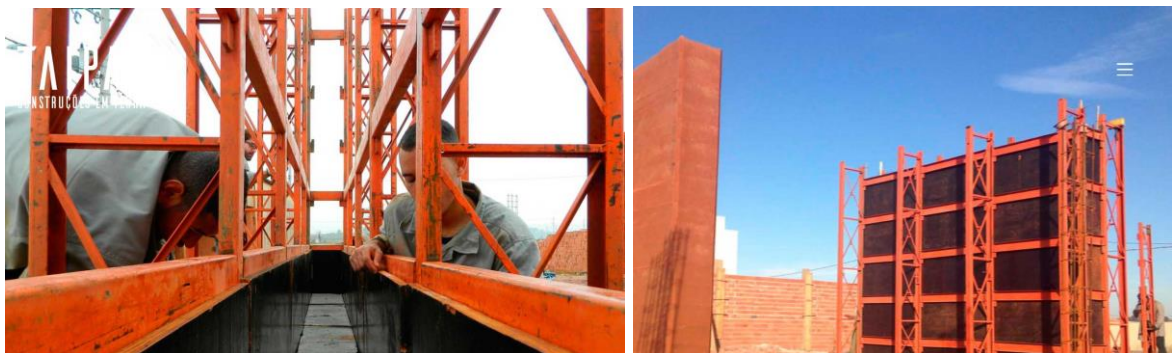
Figura 2.18 – Taipais em estrutura metálica (Adaptado de Taipal, 2015)
