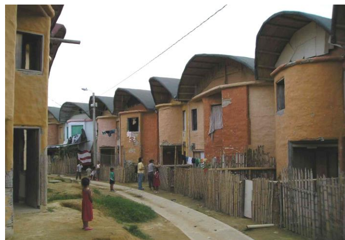
Figura 2.17 – Esq.: Fabricação de parede em taipa de mão (Tramontano e Requena, 2000). Acima: Habitações de interesse social de "quincha" (taipa de mão com bambu), na Colômbia (foto de Luzia E. Garzón, 2005)
