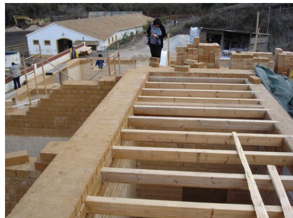
Figura 2.14 – Construção de BTC com dois pisos, paredes estruturais (1 1/2 tijolo) com entrepisos de madeira, em Aljezur - Portugal (fotos de Obede B. Faria, 2005)
