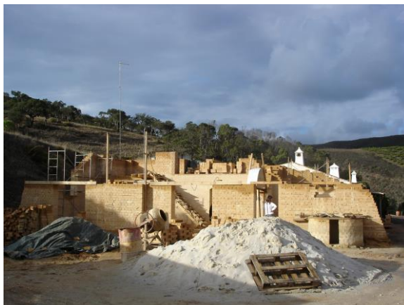
Figura 2.14 – Construção de BTC com dois pisos, paredes estruturais (1 1/2 tijolo) com entrepisos de madeira, em Aljezur - Portugal (fotos de Obede B. Faria, 2005)
