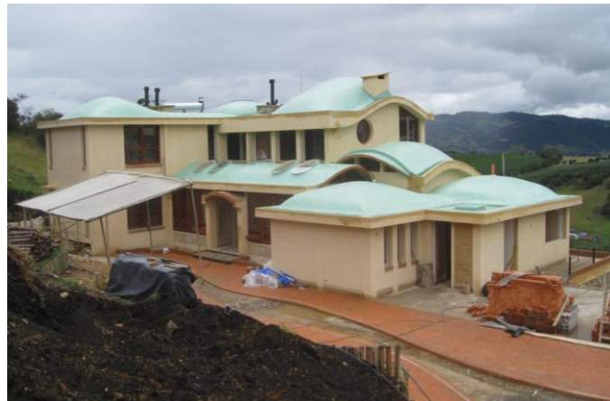
Figura 2.16 – Produção de paredes de taipa, vista interior e exterior da edificação em fase de acabamento (fotos cedidas pela Arq a Lucia E. Garzón, 2011-2012)
