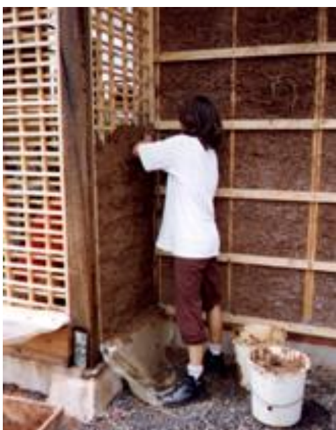
Figura 2.17 – Esq.: Fabricação de parede em taipa de mão (Tramontano e Requena, 2000). Acima: Habitações de interesse social de "quincha" (taipa de mão com bambu), na Colômbia (foto de Luzia E. Garzón, 2005)
