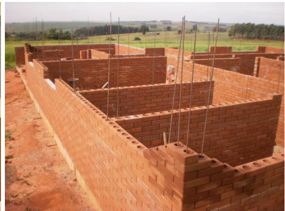
Figura 2.13 – Construção utilizando BTC, no Brasil Ecoblocos (2012)
