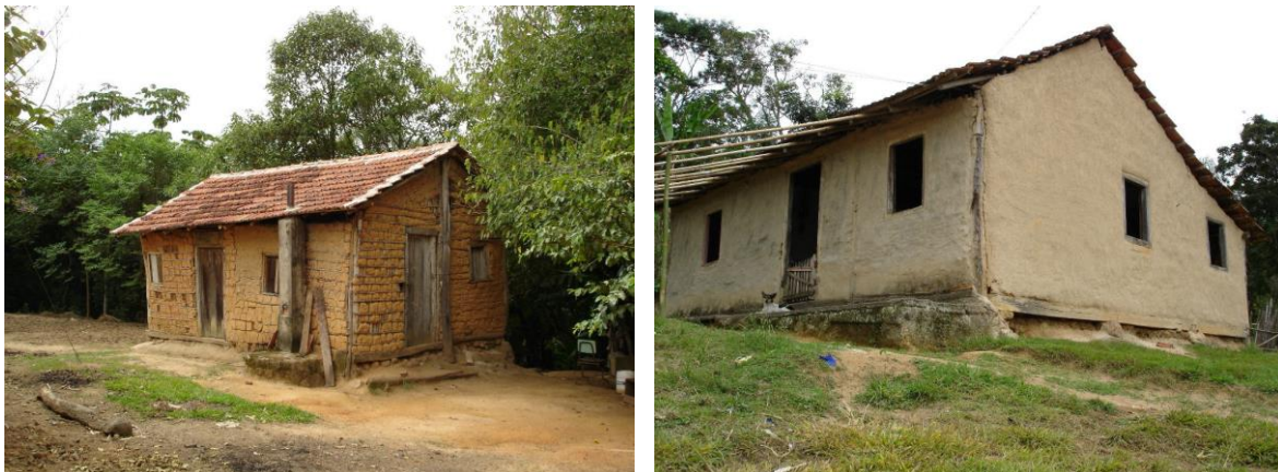
Figura 2.01 - Casas de pau a pique, na zona rural de Itaoca-SP, sem e com revestimento (Fotos de Obede B. Faria, 2005)
