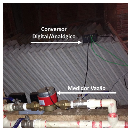
(b) Conversor de sinal entrada de água fria no reservatório térmico.
