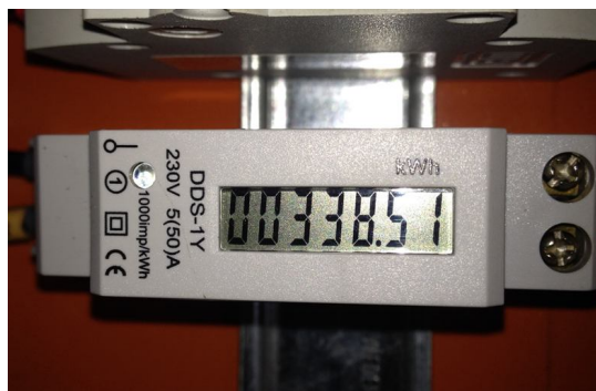
Figura 4.19 – Medidor de energia elétrica.
