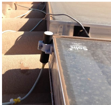
Figura 4.12 – Piranômetro em condição de instalação.
