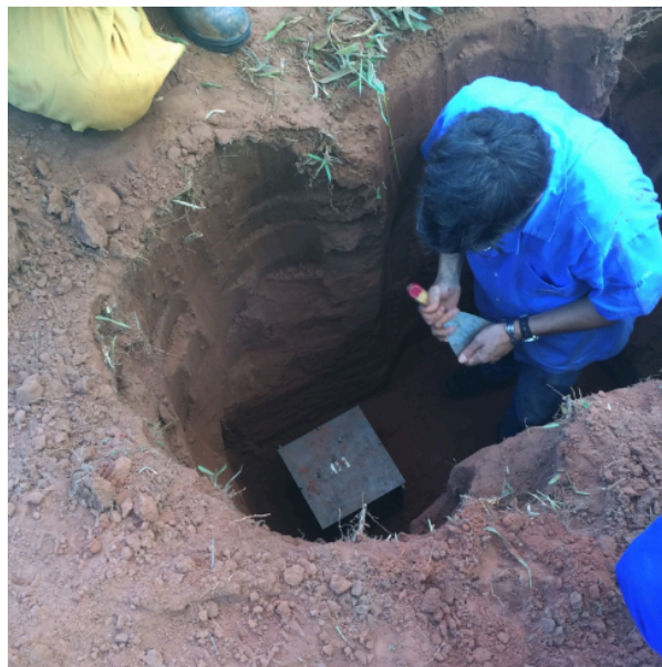
Figura 26 - Retirada de amostra indeformada.
