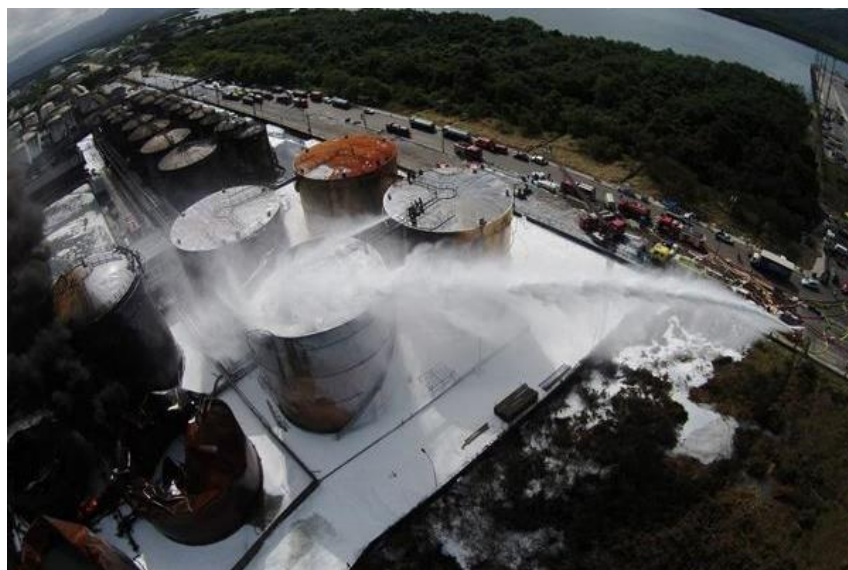
Figura 4: Incêndio e uso de espumas formadoras de filme aquoso (AFFF) no estaleiro da ULTRACARGO – SANTOS –SP Fonte: Google – Foto: Diego Lameiro/ Corpo de Bombeiros.
