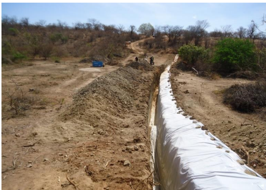
Figura 06 – Barragem subterrânea em construção – Guanambi-BA
