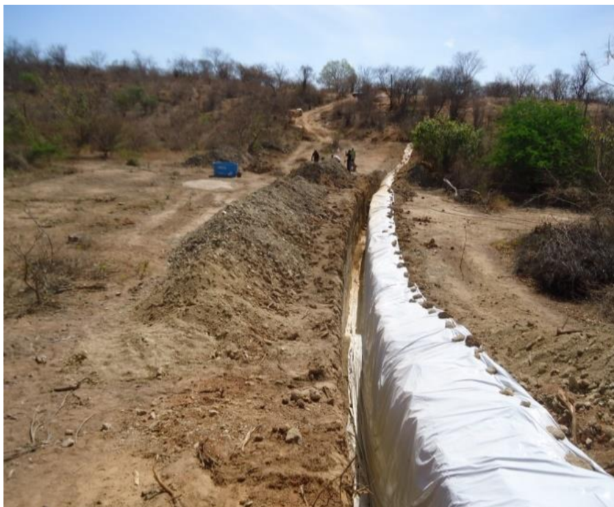
Figura 24 – Barragem subterrânea em construção
