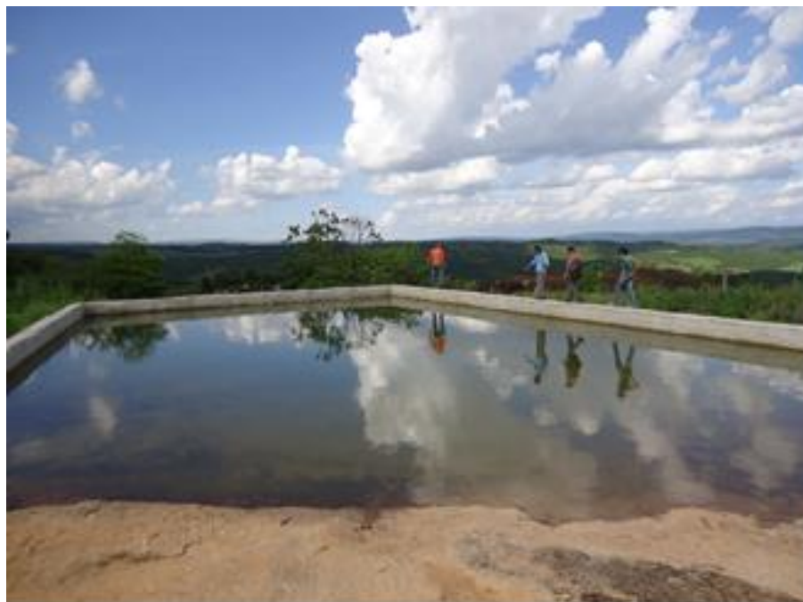
Figura 08 – Tanque de pedra
