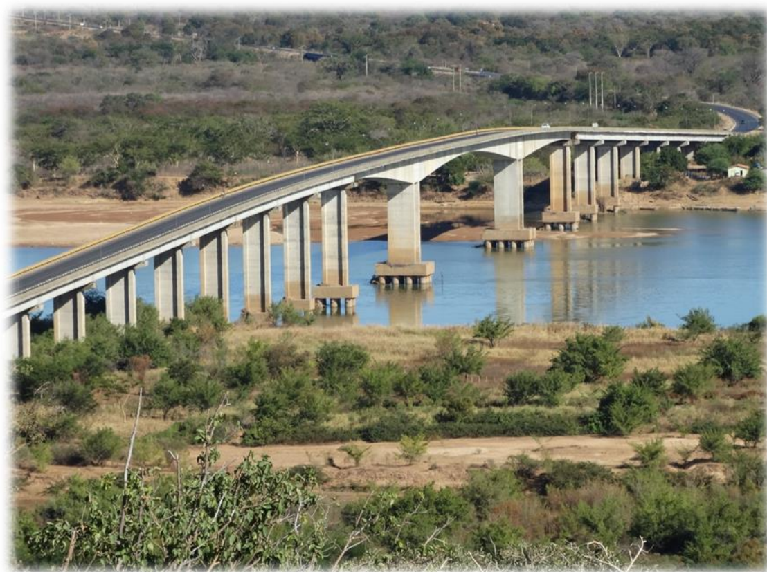
Figura 52 – Rio São Francisco sobre ponte no município de Bom Jesus da Lapa – BA Fonte: Trabalho de Campo
