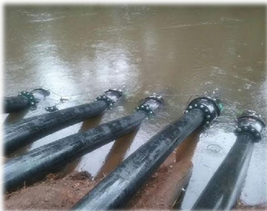
Figura 47 – Sucção de água superficial com fins para irrigação por meio de pivô central no Oeste da Bahia em junho de 2016
