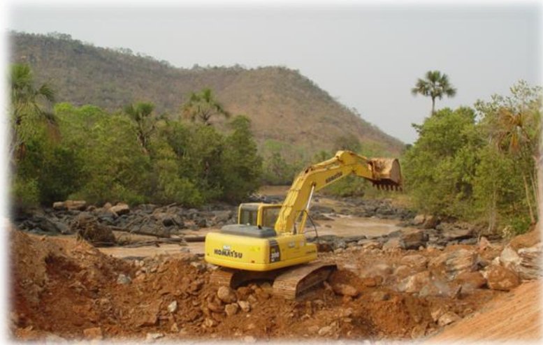
Figura 21 – Degradação do leito menor do Rio das Fêmeas após ser represado em São Desidério - 2010
