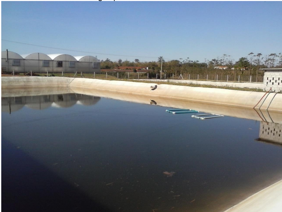
Foto 01 - Reservatório de água pluvial construído em Holambra/SP
