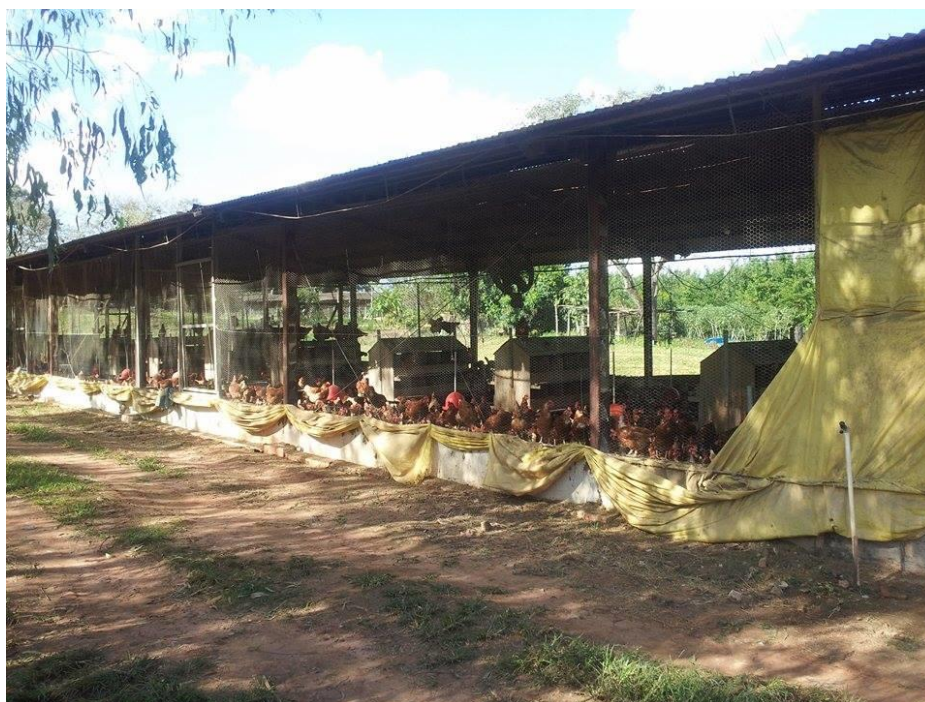
Figura 1 - Galpão utilizado no sistema caipira.
