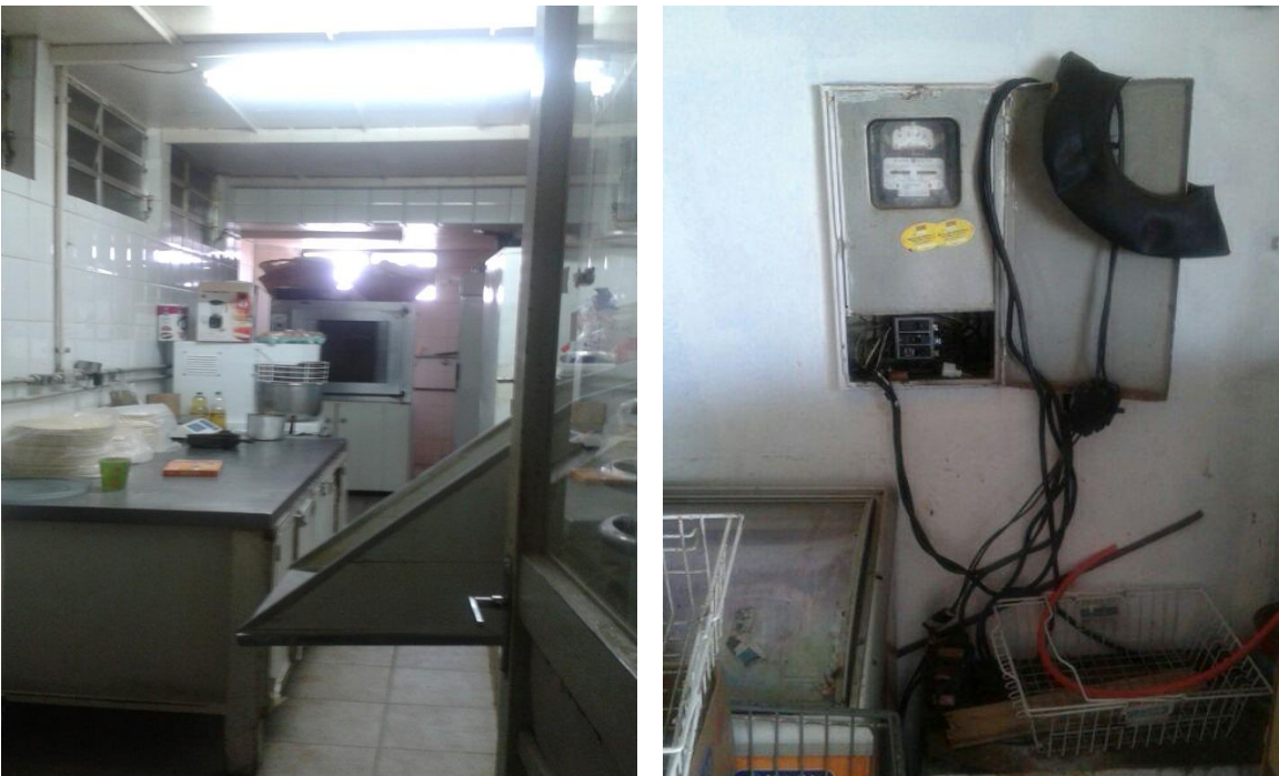
Figura 11: Supermercado G: Ambiente desorganizado e instalação elétrica inadequada.
