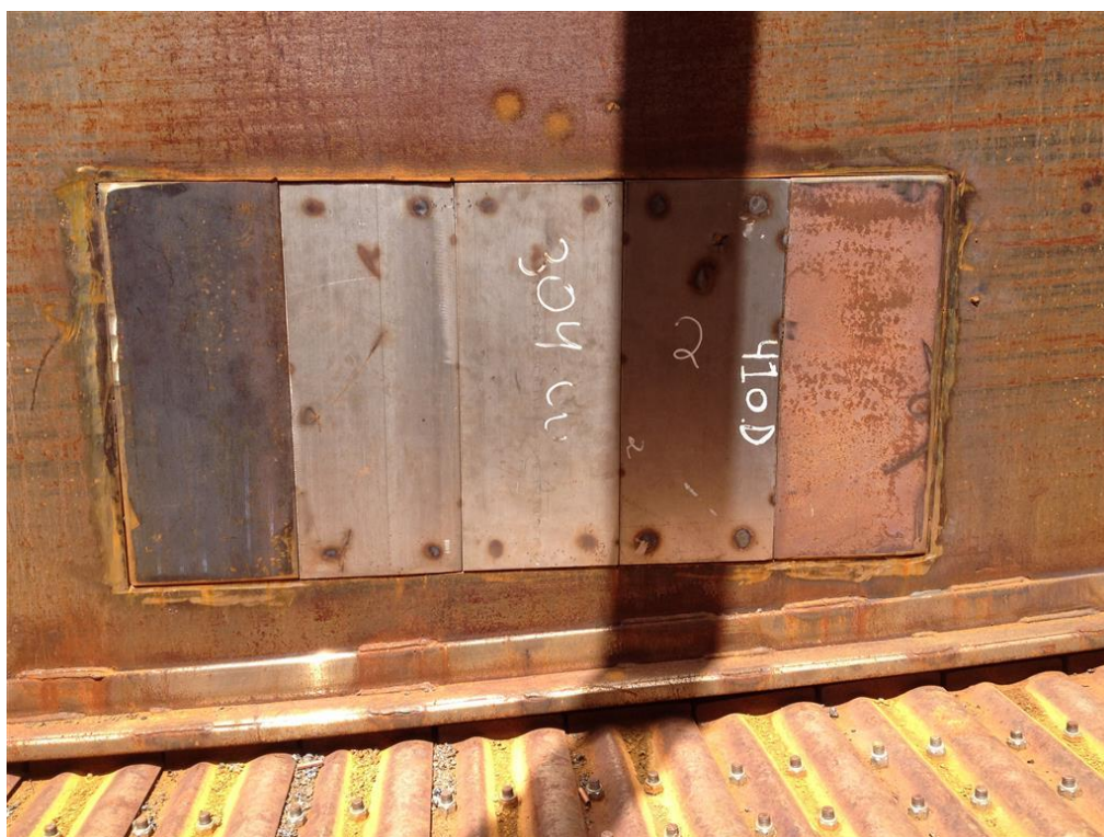
Figura 18 - Dispositivo instalado na lateral inferior do transportador Fonte: Próprio Autor
