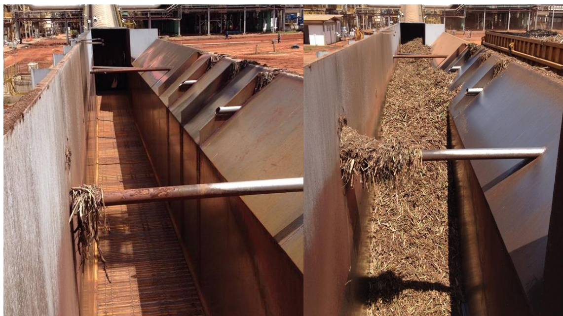
Figura 8 - Interno do transportador sem carga
