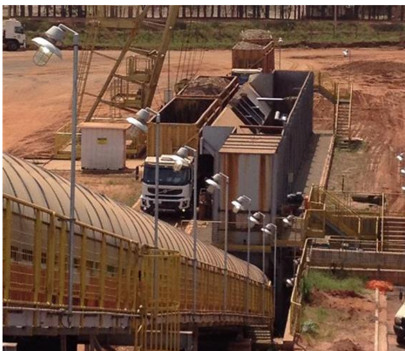
Figura 14 - Transportador TT-01 - Linha de recepção de cana picada Fonte: Raízen – Un. Paraguaçu
