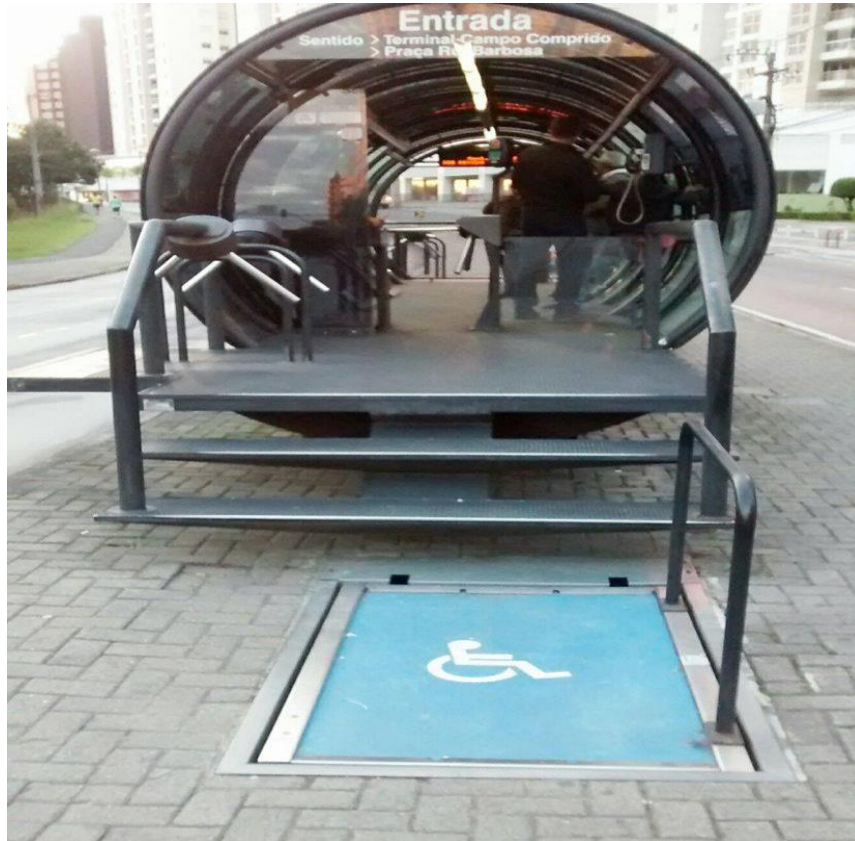
Figura 1 - Tubo - Estação Praça Rui Barbosa – Curitiba
