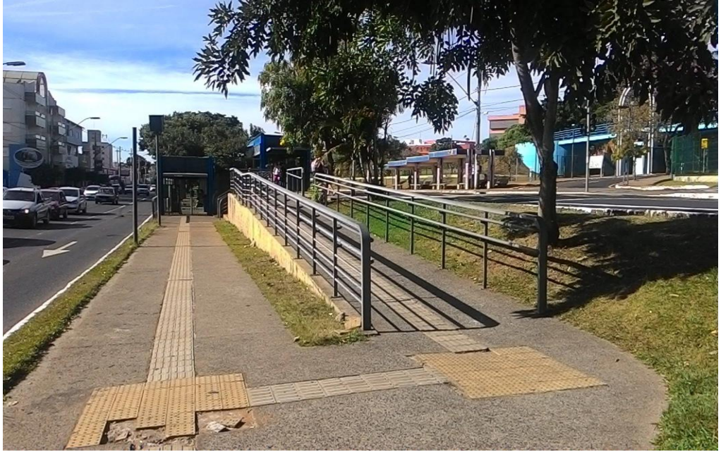
Figura 4 - Rampa de acesso ao Terminal Central – Uberlândia – MG
