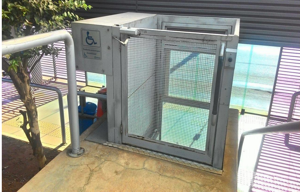
Figura 6 - Elevador de acesso para cadeirantes – Terminal Central – Uberlândia – MG
