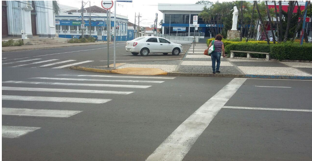
Figura 9 - Rampa da rua Major Claudiano – Franca – SP
