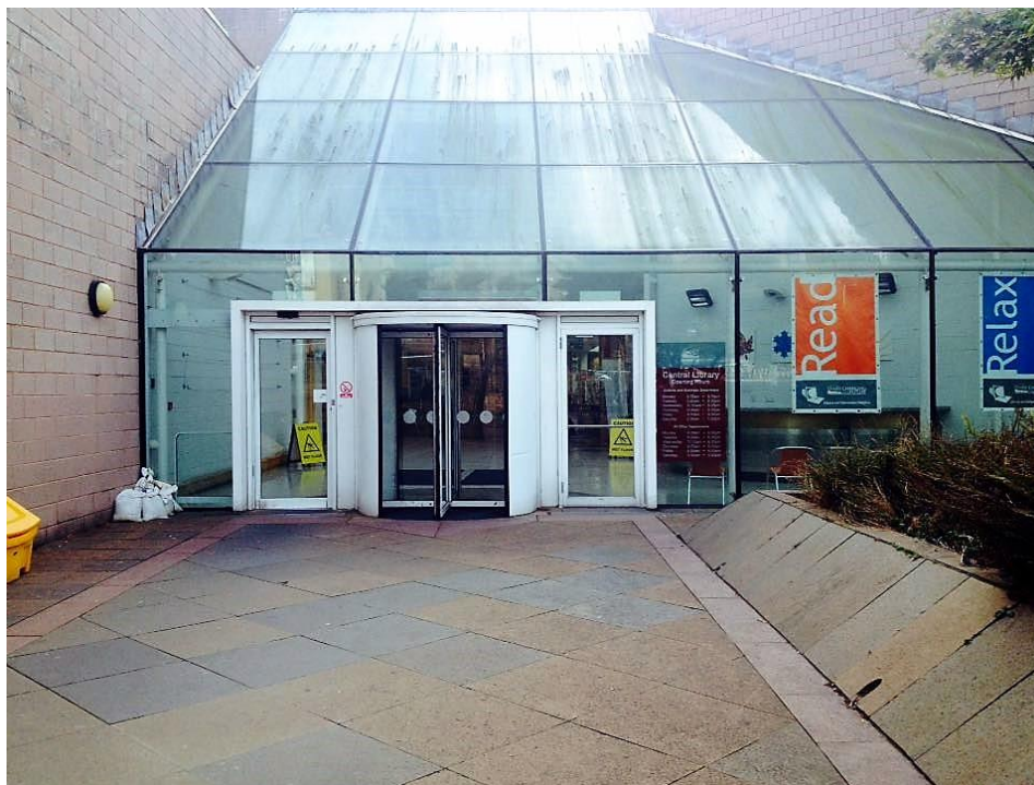
Figura 15 – Vista de uma das entradas da Central Library of Dundee
