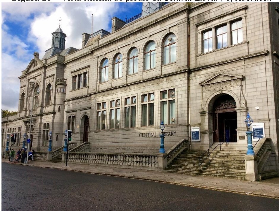
Figura 16 – Vista externa do prédio da Central Library of Aberdeen
