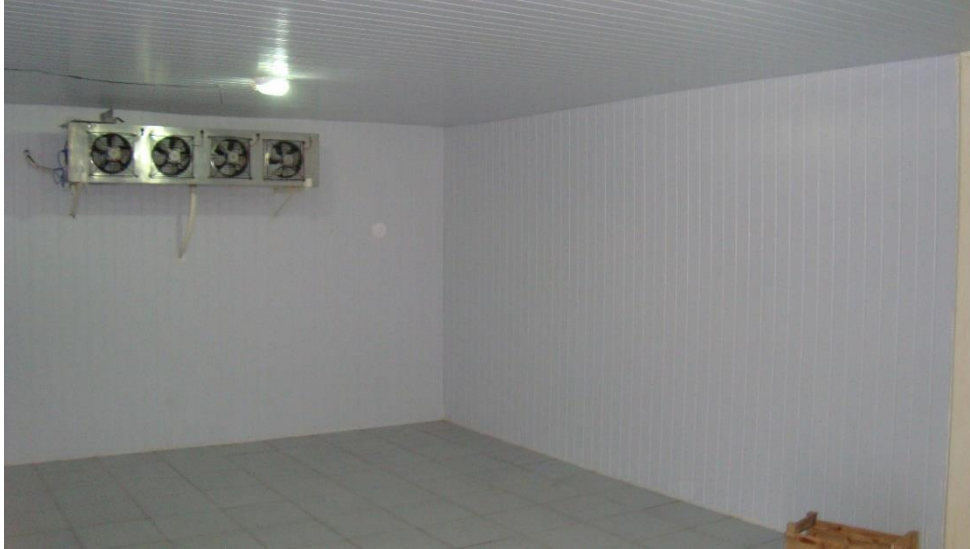
Figura 11: Parte interna da câmara fria no primeiro horário do dia, antes dos produtores chegarem para descarregamento.
