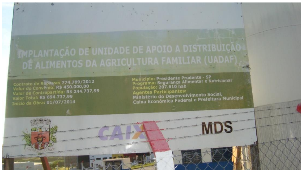
Figura 14: Anexo a Unidade de Alimentação Escolar, prédio já terminado de Apoio a Distribuição de Alimentos da Agricultura Familiar (UADAF).
