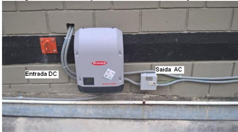
Figura 42 - Instalação do inversor na rede experimental
