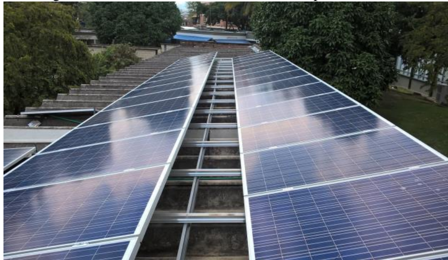
Figura 41 - Painéis solares alinhados e dispostos em série.
