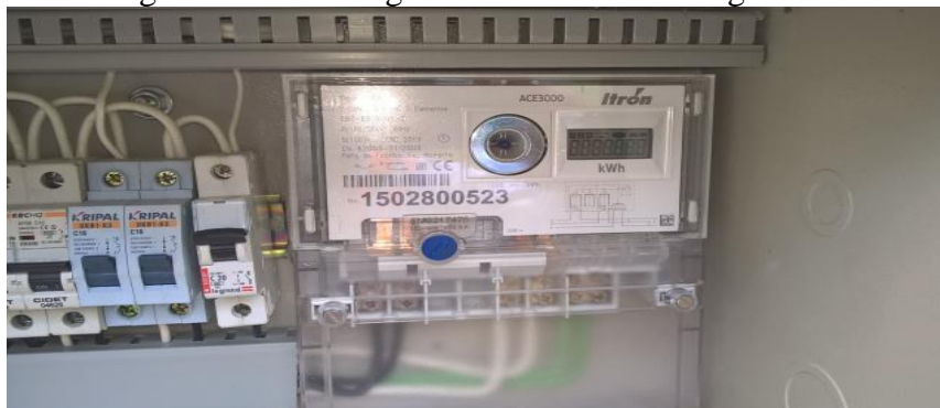
Figura 43 - Montagem do medidor de energia solar
