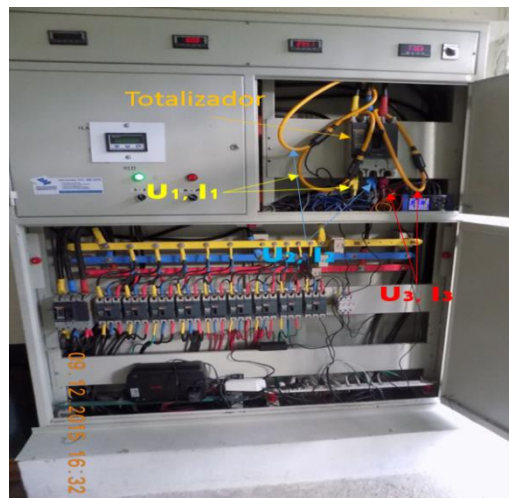
Figura 4 - Conexões do analisador de energia
