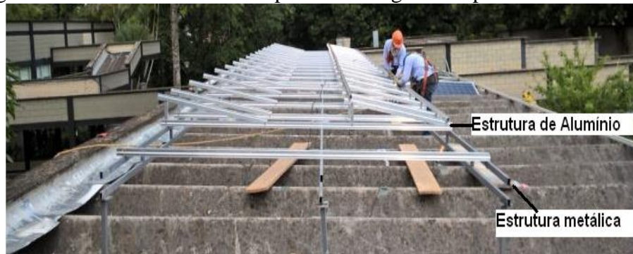
Figura 40 - Plataforma metálica para a montagem dos painéis fotovoltaicos.
