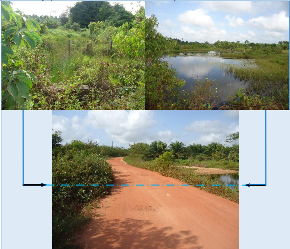
Figura 40: Intercepção de rio, trecho da Rodovia PA-322 (município de Bonito)
