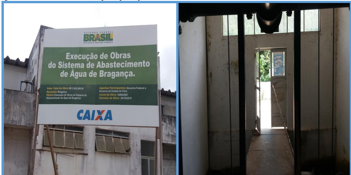
Figura 20:Previsão de reforma e porta principal da ETA
