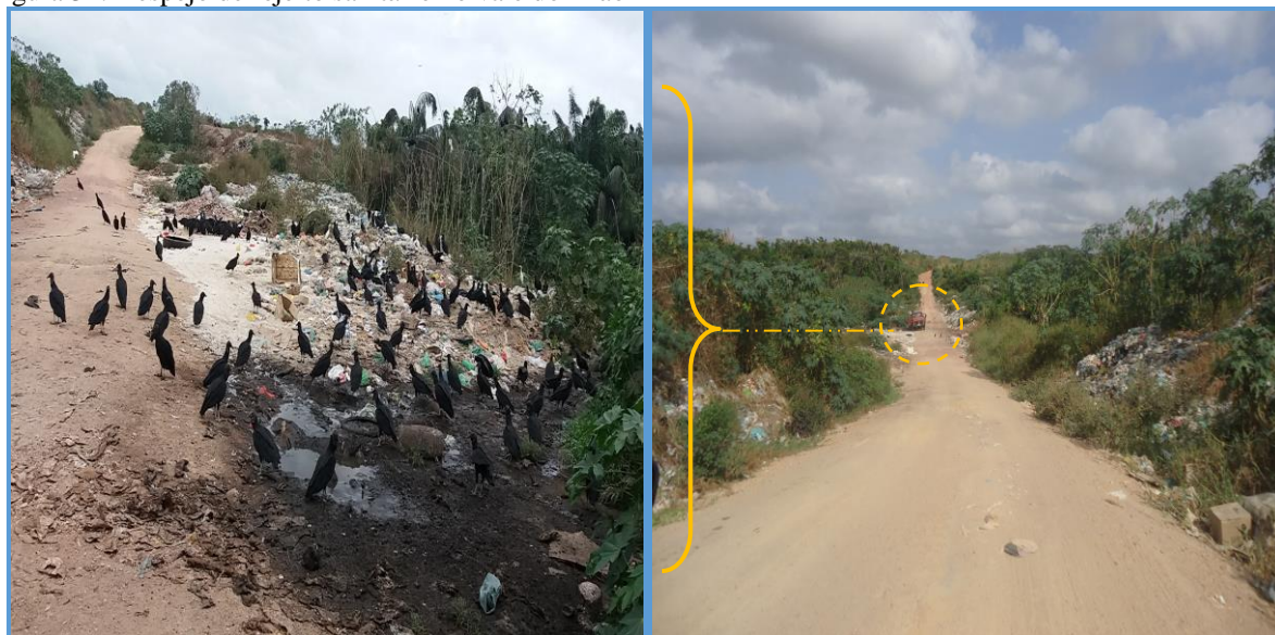
Figura 32: Despejo de rejeito sanitário no vale do lixão
