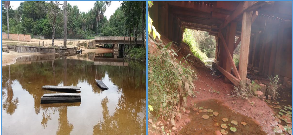
Figura 39: Erosão e assoreamento em cursos d' água na bacia hidrográfica do rio Caeté
