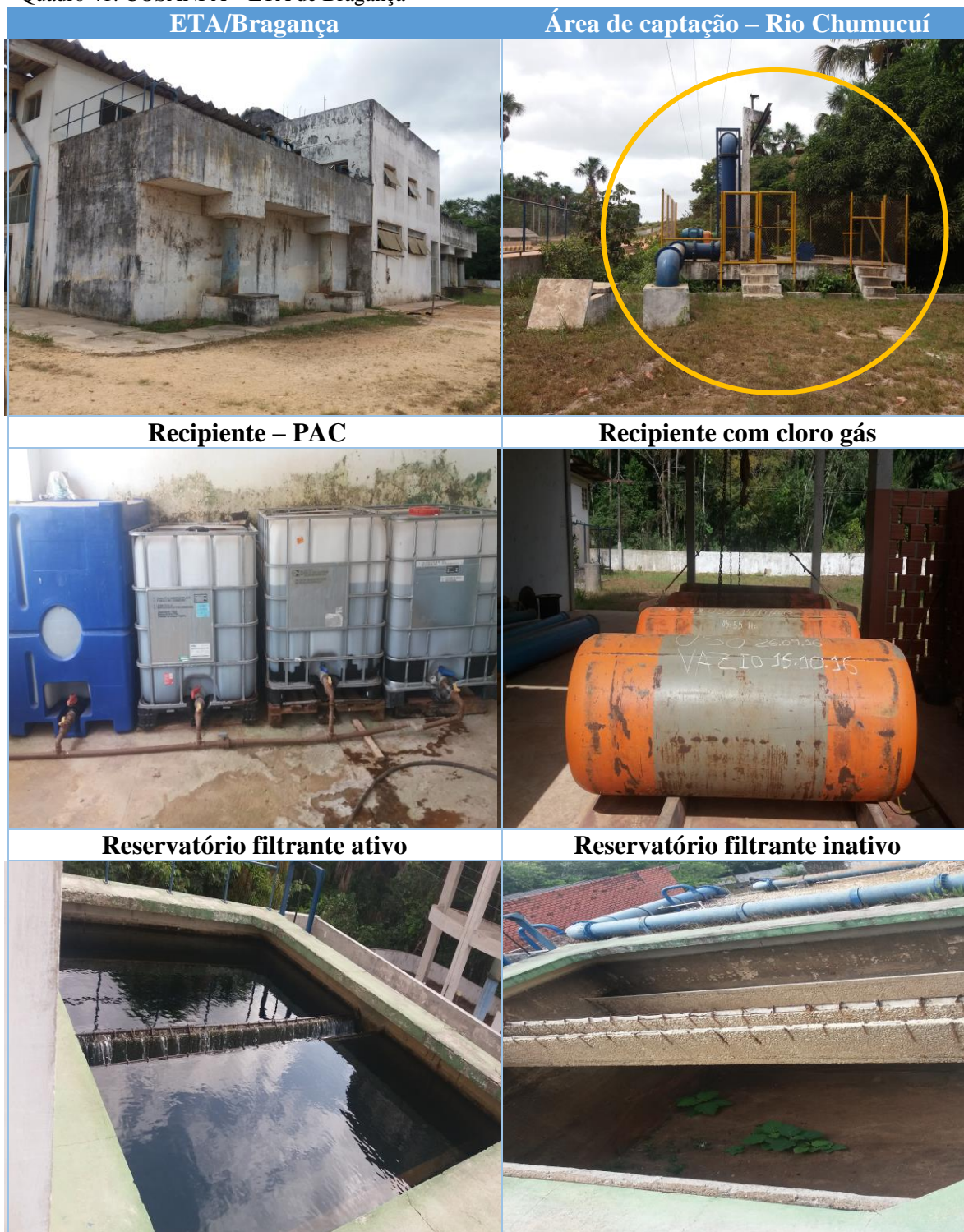
Quadro 41: COSANPA – ETA de Bragança
