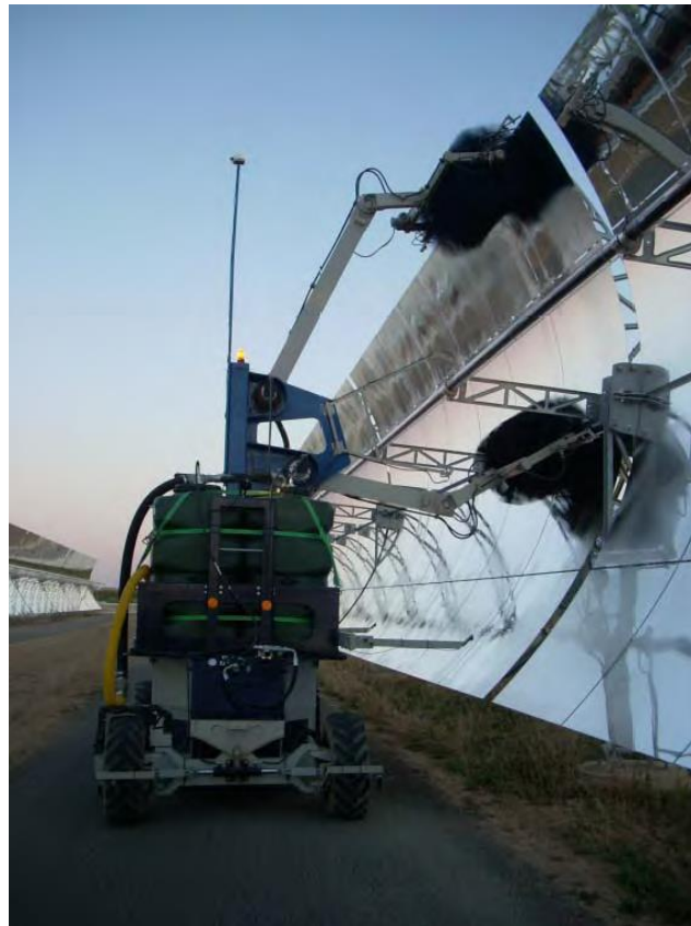
Figura 26 - PARIS - Sistema autônomo de limpeza de calhas parabólicas
