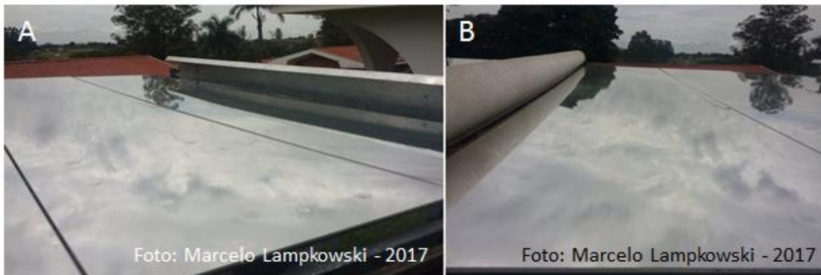
Figura 61 - Situação da sujidade nos espelhos registrada em 06/02/2017
