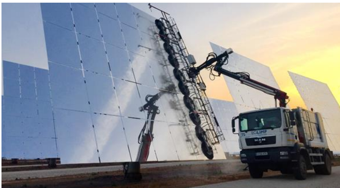
Figura 23 - Limpeza de heliostato usando caminhão e água pressurizada na usina Gemasolar
