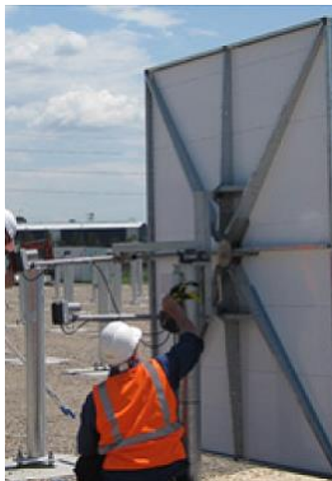
Figura 19 - Heliostato com duas unidades lineares e movimentação no eixo horizontal primário
