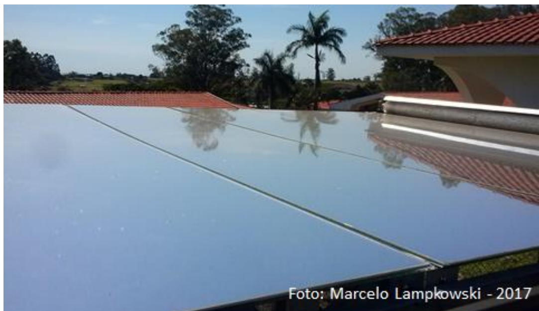
Figura 63 - Situação da sujidade nos espelhos registrada em 23/02/2017
