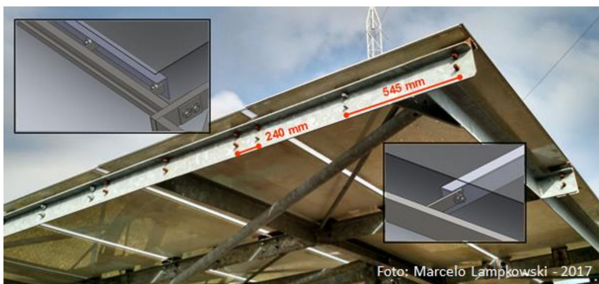
Figura 31 - Fixação do mecanismo de limpeza no heliostato
