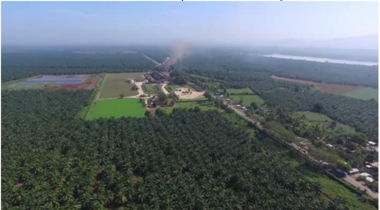
Ilustración 13. Foto área de la planta extractora de Maríalabaja
