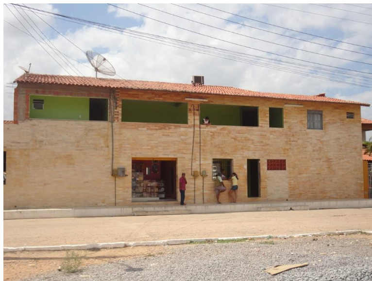
Figura 44 – Fotografia da fachada da Pousada Leal.
