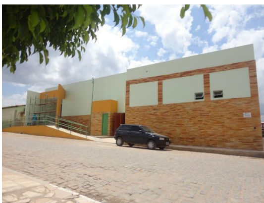
Figura 84 - Fotografia do Centro de Eventos de Nova Olinda, julho/2013.
