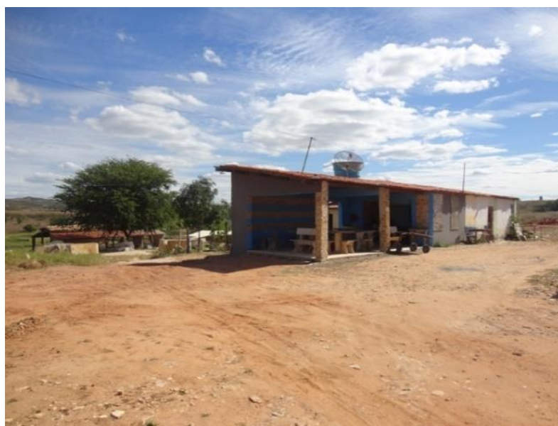
Figura 29 – Fotografia do Comércio de Pedra Cariri, FORM Pedras
