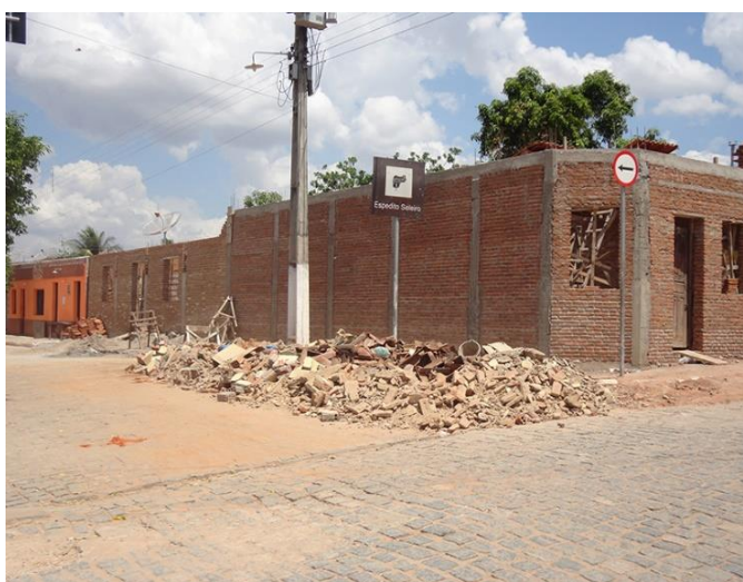
Figura 86 - Fotografia Museu do Couro em construção com a oficina contígua em cor destacada do lado esquerdo.
