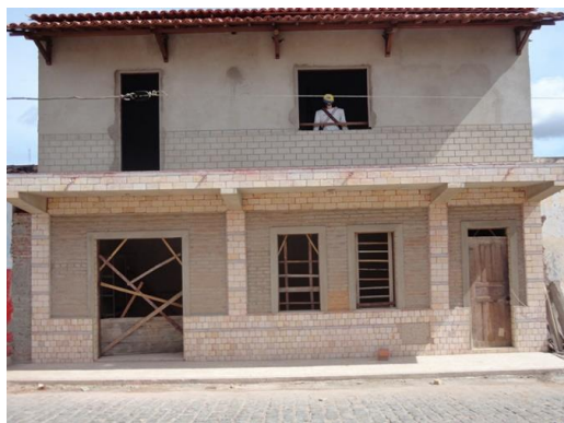
Figura 88 – Fotografia da fachada da Loja do Tesouro Vivo da Cultural Cearense, Espedito Seleiro em construção.
