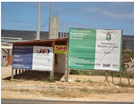
Figura 85 - Fotografia com vista parcial das obras de construção de uma Escola Estadual de Educação Profissional.
