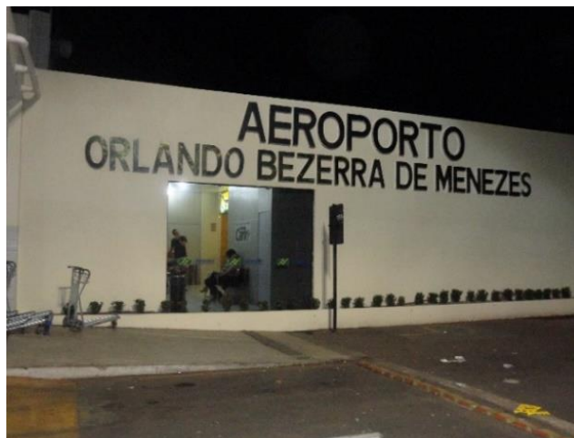
Figura 14 - Fotografia de vista externa do aeroporto de Juazeiro do Norte.
