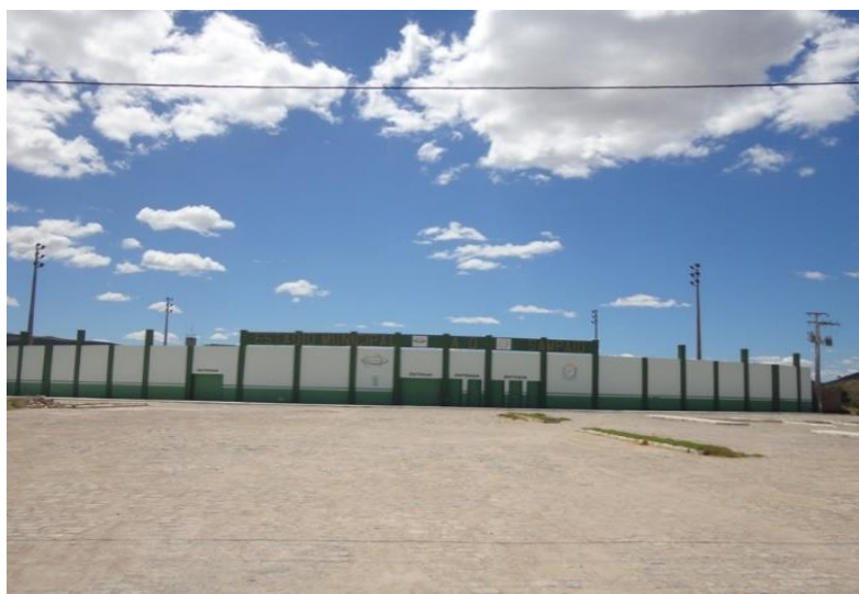
Figura 24 – Fotografia da Estádio de Futebol de Nova Olinda.
