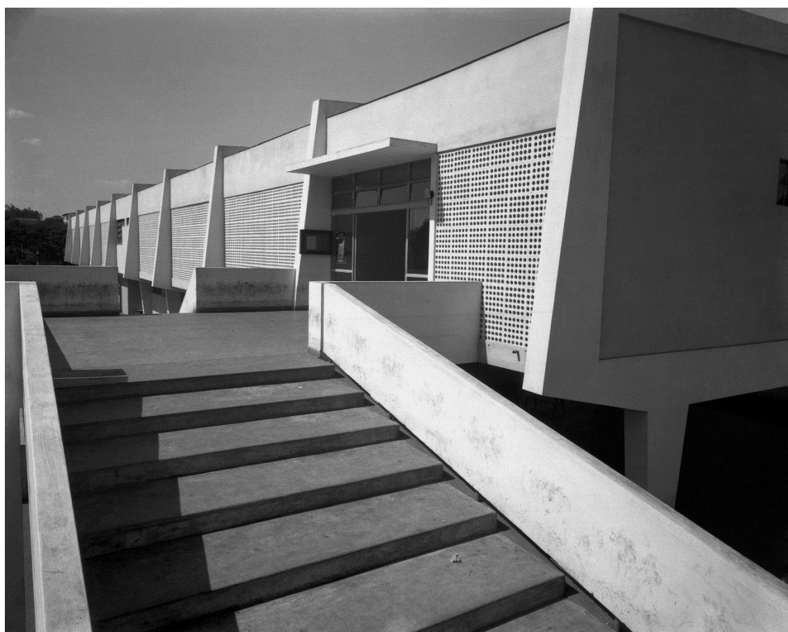
Imagem 12 – Fotografia de Tony Miyasaka, feita no ano de 1962. É o prédio do Serviço Social do Comércio – SESC, de Ribeirão Preto, localizado na rua Tibiriçá, nº50, entre a rua Visconde do Rio Branco e a avenida Francisco Junqueira. Fonte: Arquivo Miyasaka.
