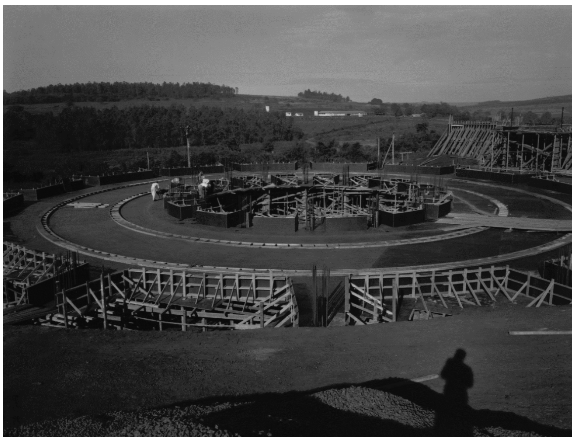
Imagem 40 – Fotografia de autoria de Tony Miyasaka, realizada entre 1960 e 1965. Início das obras para a construção do prédio da Faculdade de Odontologia do campus da USP em Ribeirão Preto. O prédio ainda estava no momento de realização das obras para a realização de sua fundação, como é possível ver pelas estruturas de madeira que o envolvem.
