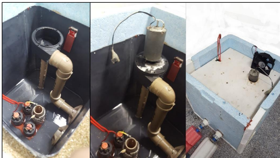
Figura 32 - Aquecedor e bomba do trocador de calor.
